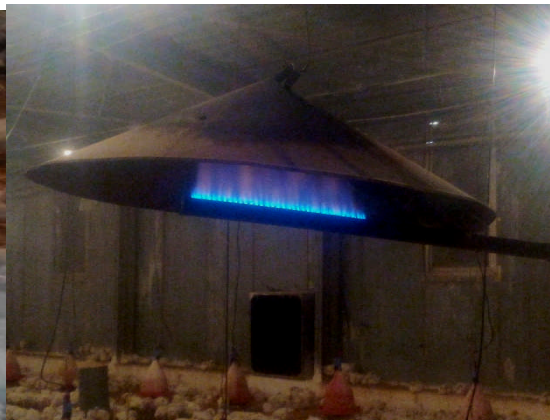
Figure 15 : éleveuse type radiant
