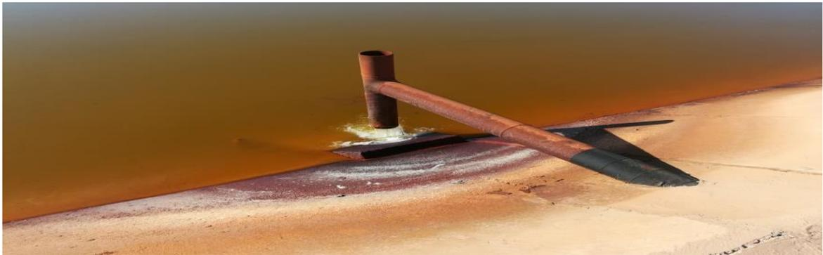
Figure III -29 : arriver d'eau à partir d'un CPI au bassin d'évaporation
