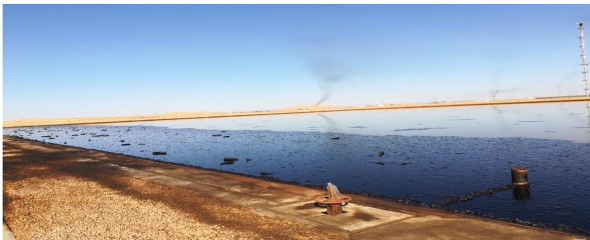
Figure III -32: formation couche brute a la surface de bassin evaporation
