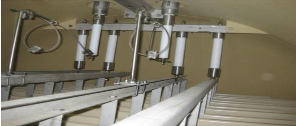
**Figure I -10 : Vue des électrodes, DUAL POLARITY NATCO**
