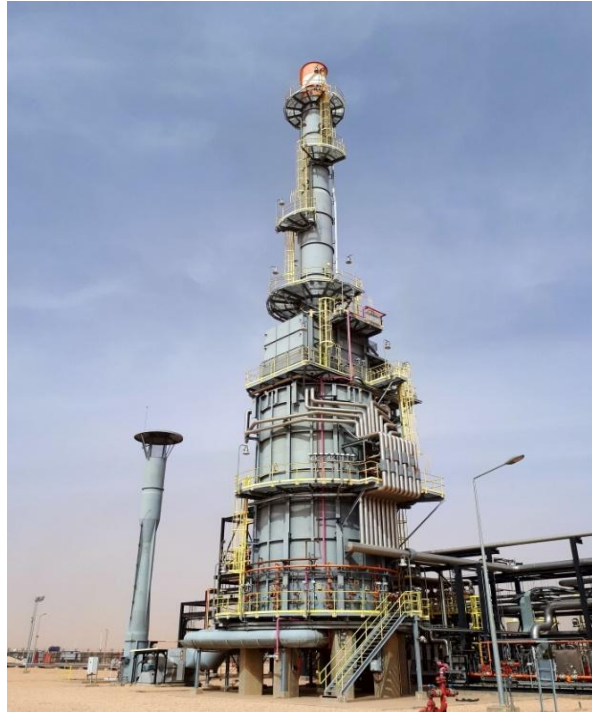
Figure II.2 : Le four d'huile caloporteuse
