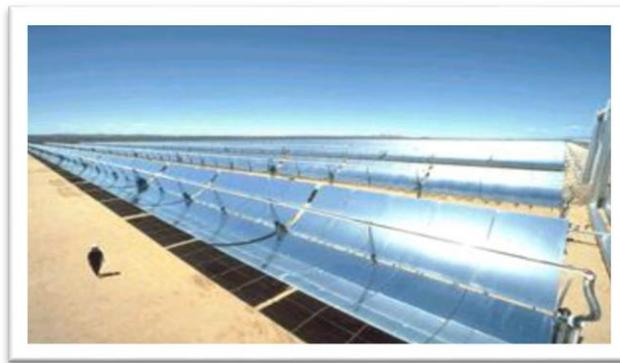
**Figure 1.4 : Capteur cylindro-parabolique**
