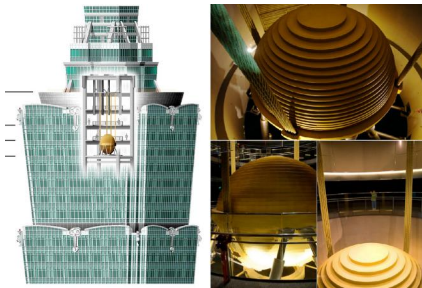
Figure 2.1: TMD pendulaire au sommet de la tour de Taipei 101[02].
