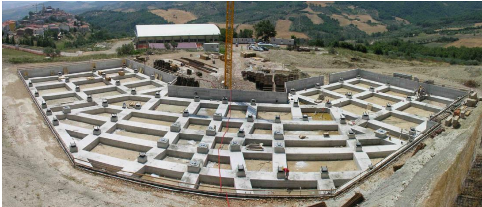
Figure 2.3: Exemple d'application d'isolation à la base [22].
