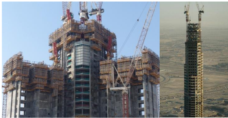
Figure 1.14: Système structural par noyau.
