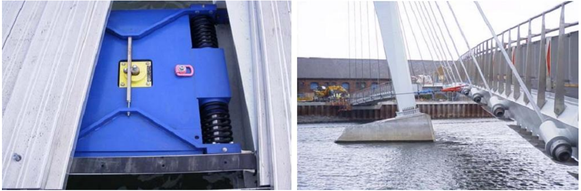
Figure 2.20: Application de TMD: Passerelle de Tawe à Swansea, l'Angleterre.
