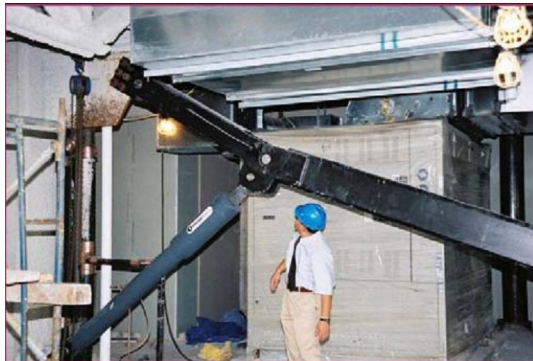
Figure 2.17: Système de contreventement à articulation, Huntington Boston.
