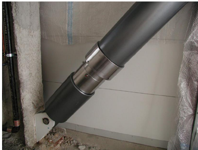
Figure 1: Amortisseur visqueux de Taylor.
