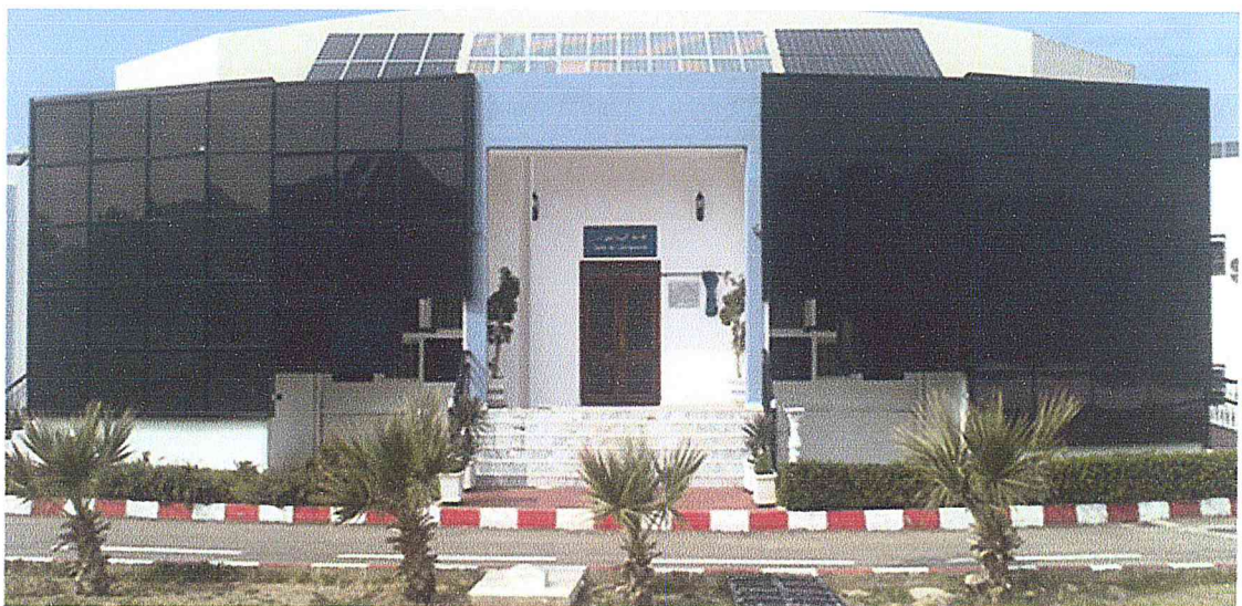
Figure II.1 : La centrale photovoltaïque multi-technologie de l'UDES
