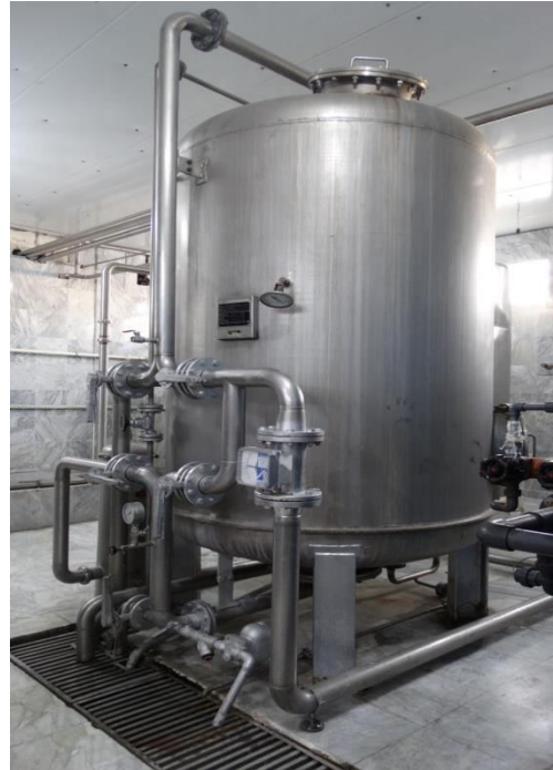
Figure 22: Traitement de l'eau de forage par chloration selon les normes exigées pour l'eau de procès.
