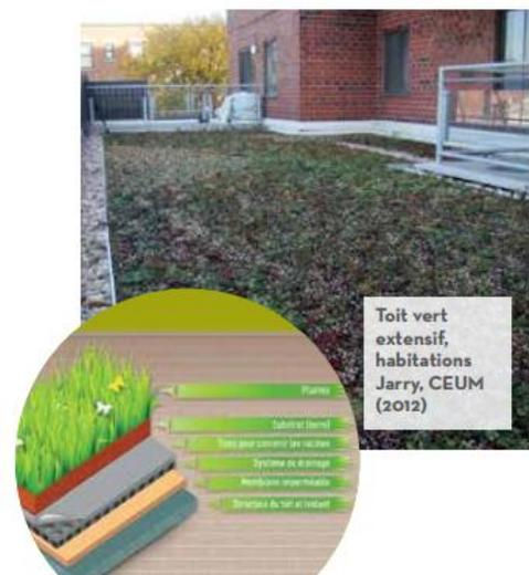
Figure 17 : Toit extensif. Source 33)
