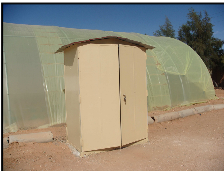
Figure 4.15 Abris des enregistreurs
