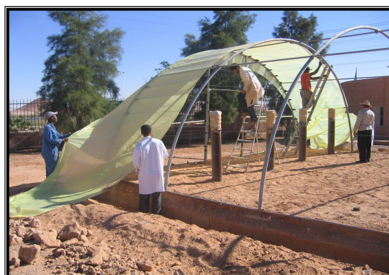
Figure 4.2 Montage de la couverture
