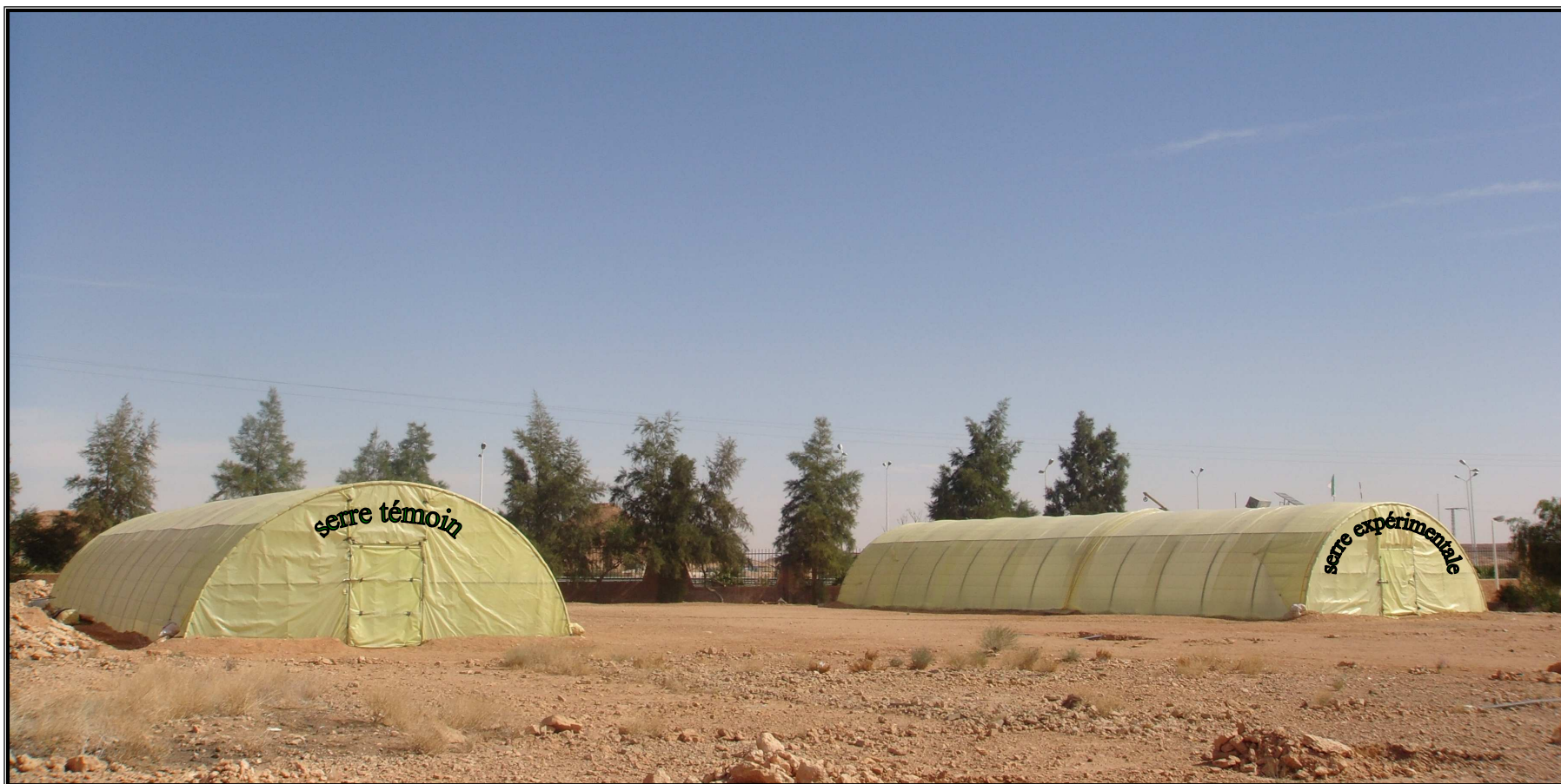
Figure 4.33 Vue d'ensemble des serres sur le site de l'URAER (Ghardaïa)
