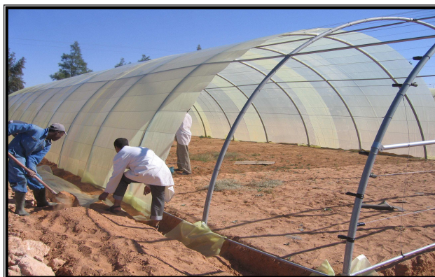
Figure 4.3 Fixation du film plastique
