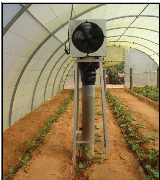
Figure 4.9 Entrée de l'air par Ventilation
