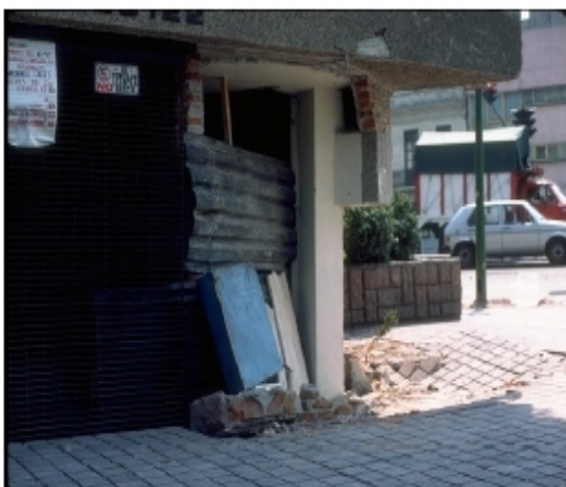
Figure 2.5: Endommagements des structures au niveau de la fondation après le séisme de Guerrero- Michoacán (Mexique, 1985). (Images communiquées par Alain Pecker)
