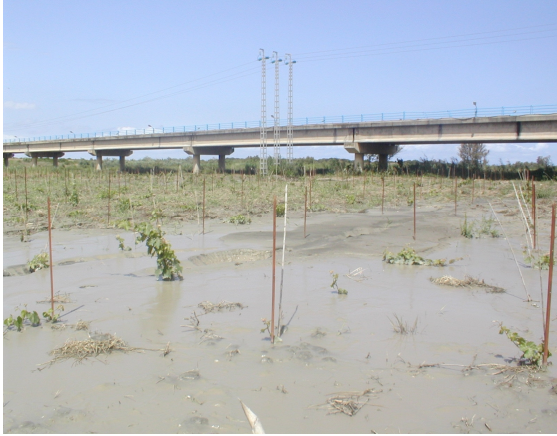
Figure 2.6. Liquéfaction près d'un pont d'Isser
