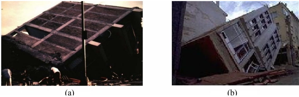
Figure 2.11: Rupture rotationnelle par perte de la capacité portante ; (a) bâtiment de la Ville de Mexico fondé sur pieux flottants après le séisme de Guerrero-Michoacán (Mexique, 1985) et (b) bâtiment de la ville de Adapazari (séisme de Koçaeli (Turquie, 1999).
