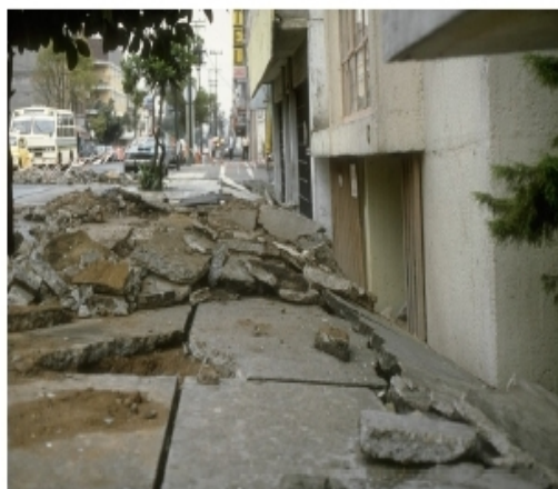
Figure 2.5: Endommagements des structures au niveau de la fondation après le séisme de Guerrero- Michoacán (Mexique, 1985). (Images communiquées par Alain Pecker)
