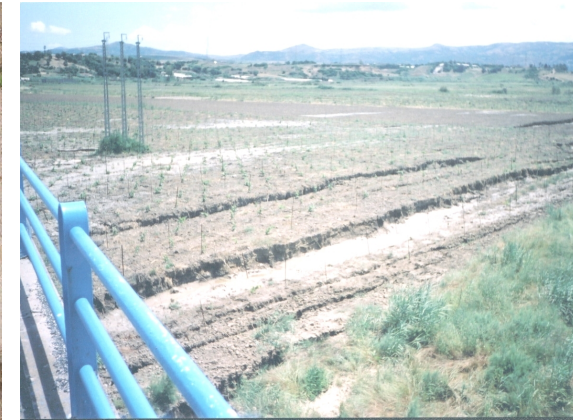
Figure 2.9. Fissures induites par la direction du mouvement du sol suivant la liquéfaction.
