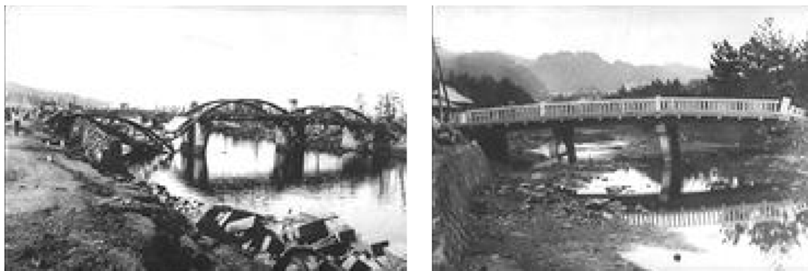
Figure 2.2 Le séisme de Kanto (japon) de 1923. Grands tassements et rotations au niveau de la fondation de piles de ponts. (Source : NISEE library, http://nisee.berkeley.edu ).
