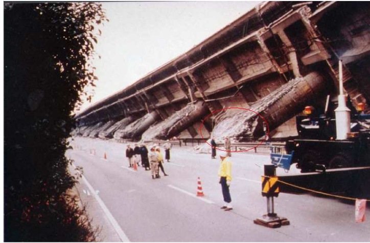
Séisme de Kobé –Japon 1995 [26]
