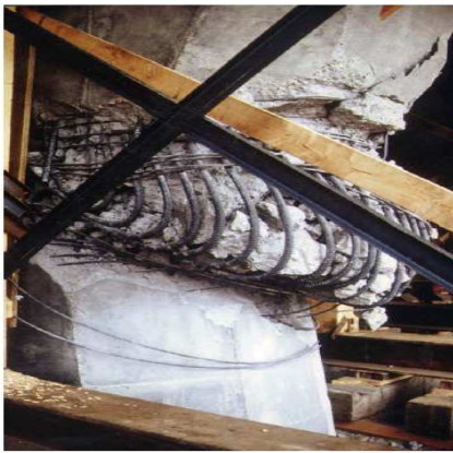
Pont State 118/Mission Gothic [11], Séisme de Northridge –Los Angeles 1994
