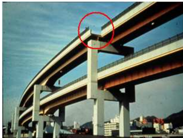
Séisme de Kobé –Japon 1995 [26]
