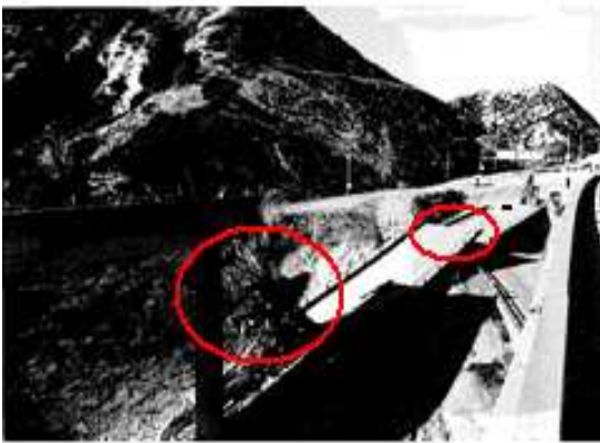
Pont 14 North Connector [11], Séisme de Northridge –Los Angeles 1994
