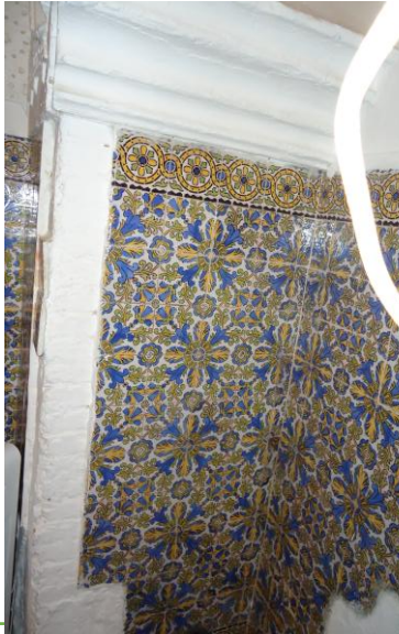
Figure 28.01 : Traitement de la façade en faïence
