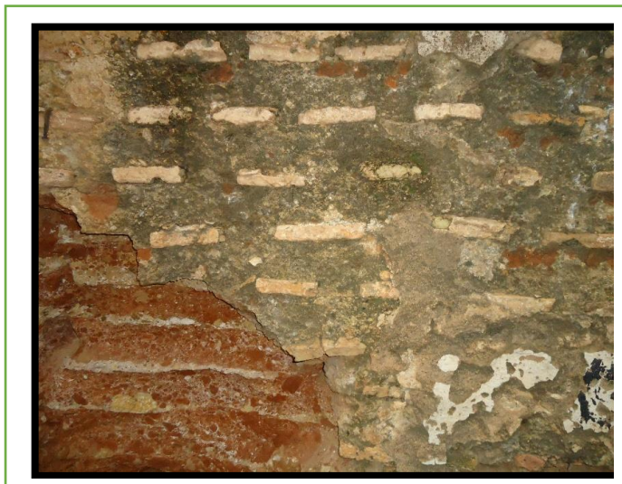
Figure 12 : les matériaux (la pierre en tuf).
