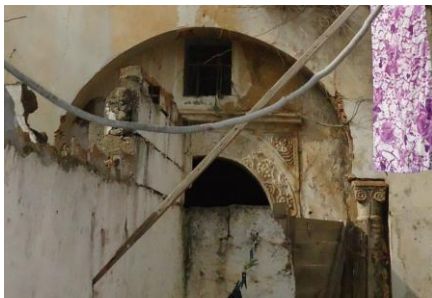
Figure 29.04 : Arc plein cintre en stuc
