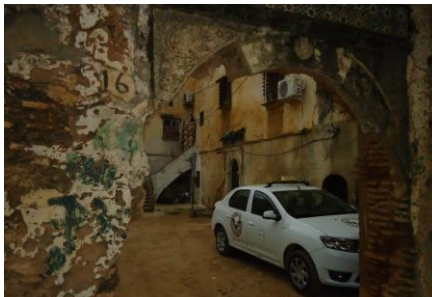
Figure 19.04 : Traitement des entrées en stuc
