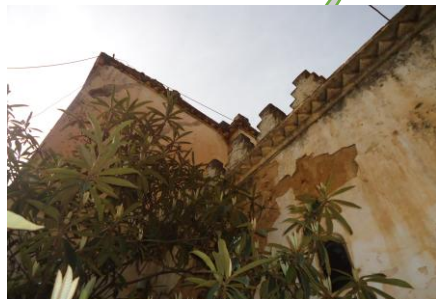
Figure 26.03 : traitement des couronnements de la façade
