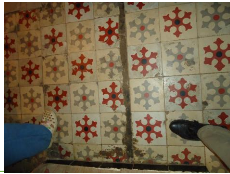
Figure 28.02 : Traitement de sol en carrelage
