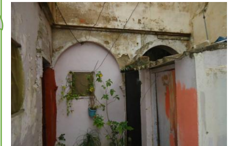
Figure 16.05 : traitement des façades en saillies
