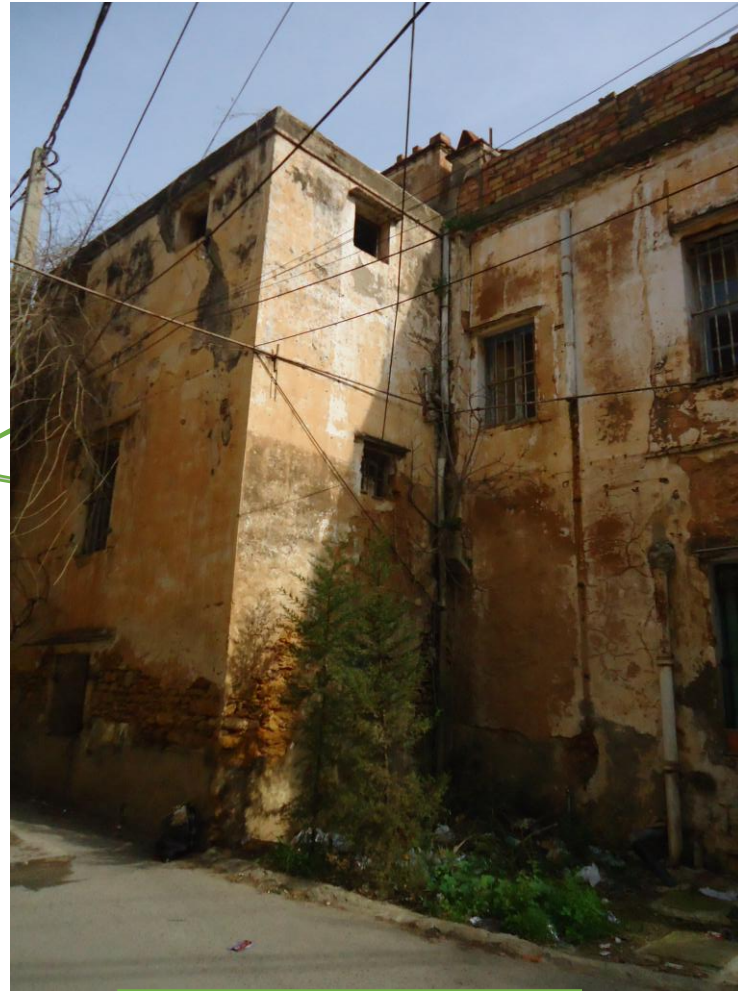
Figure 26.04 : la façade sur rue
