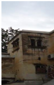
Figure 17.03 : traitement des couronnements de la façade
