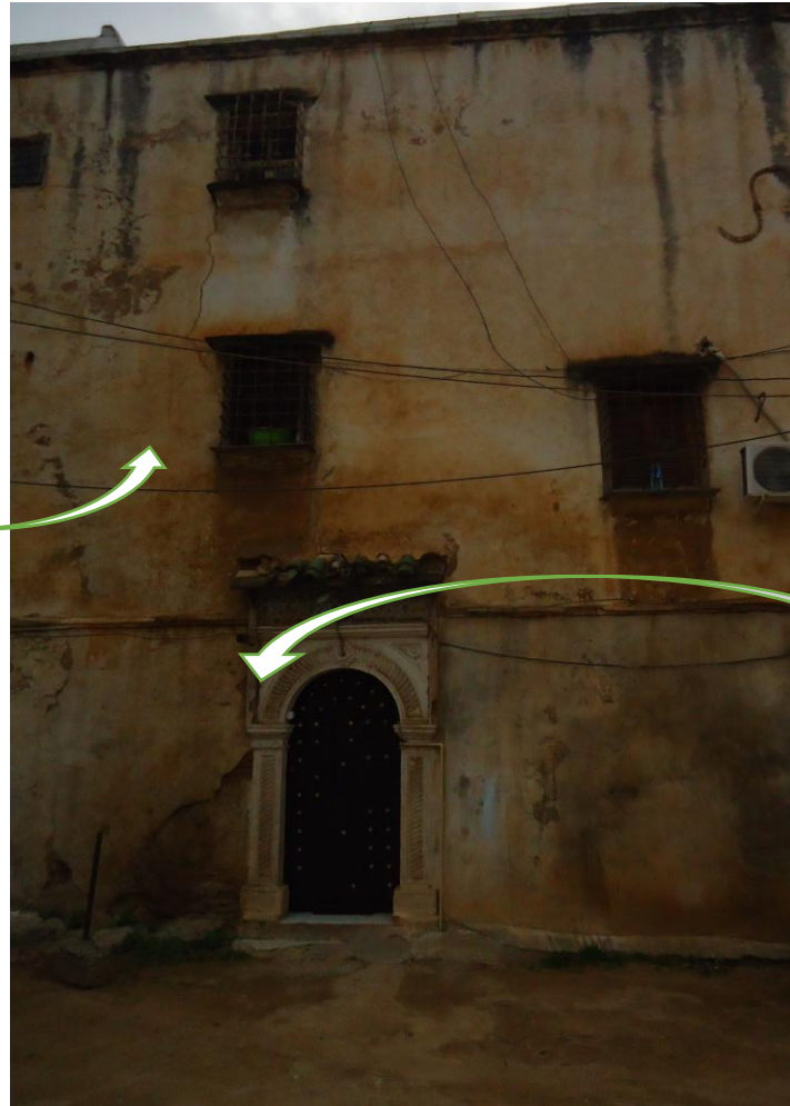
Figure 17.04 : la façade sur rue
