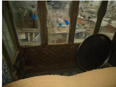
Figure 18.02 : Traitement de (le kabou de l'intérieur) kabous en bois
