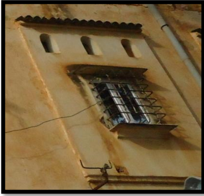
Fenêtre avec barrodage en fer surmontée par trois ouvertures en arcade surmontées eux aussi par une série en tuile.
