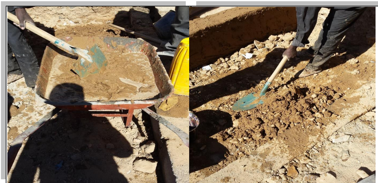
Fig 3.9. L'argile dans ksar el Mihane Source : Auteur
