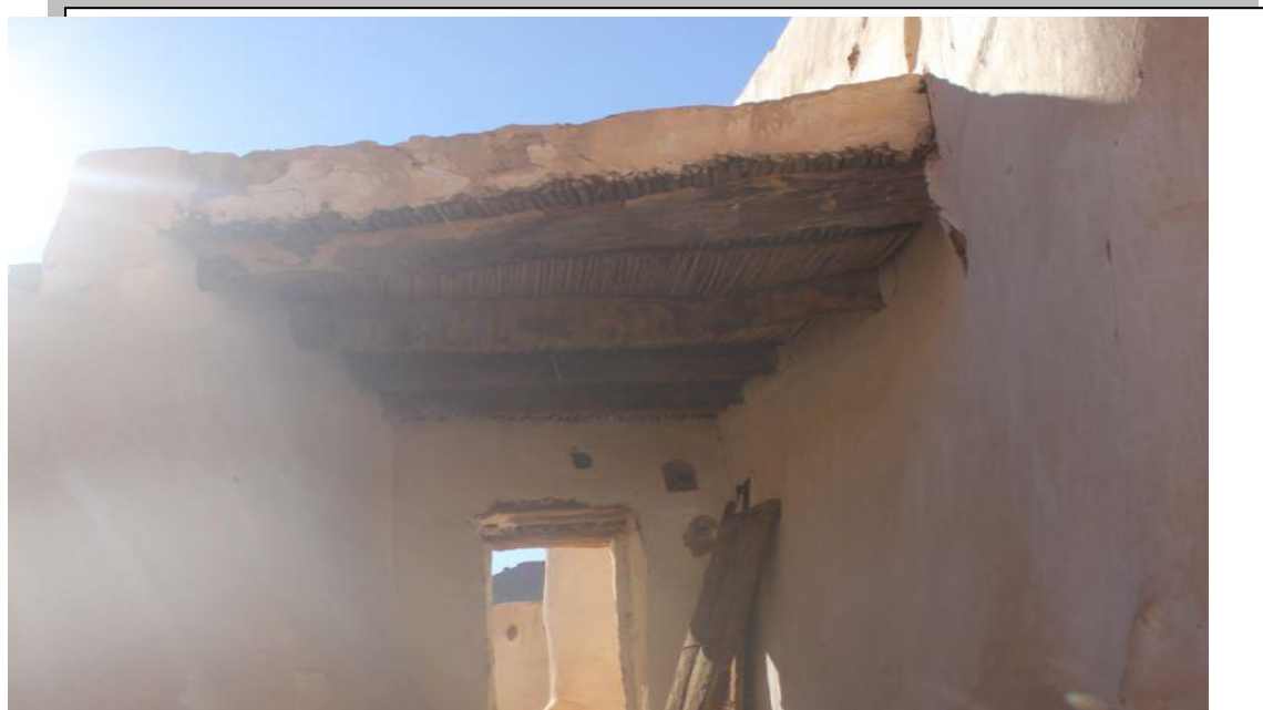
Fig 3.13. Plancher traditionnel dans ksar el Mihane Source : Auteur
