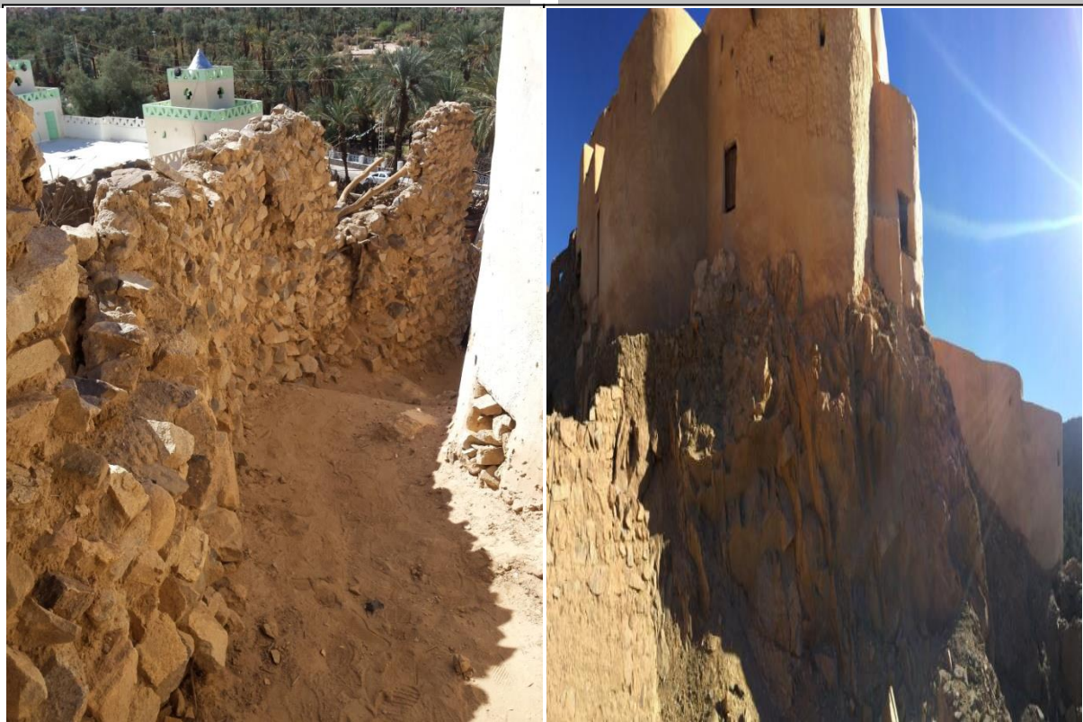
Fig 3.12. Les murs du ksar el Mihane Source : Auteur
