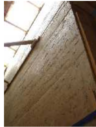
Figure : un mur en pisé
