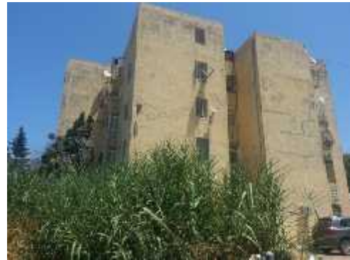
les habitats collectives à côté du site Source : Source : prise par l'auteur 2017
