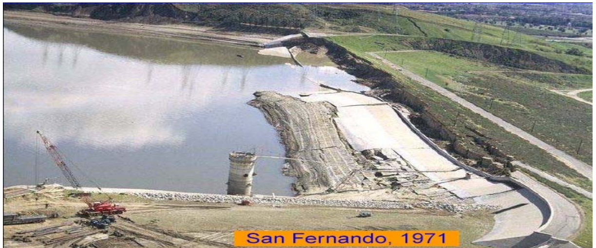
Figure 1.6 : Rupture de barrage (San Farnando, 1971) [2].
