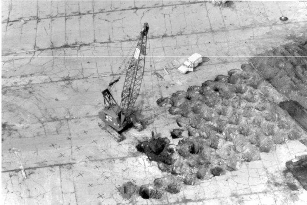
Figure 1.20 : Technique de la compaction dynamique [17].
