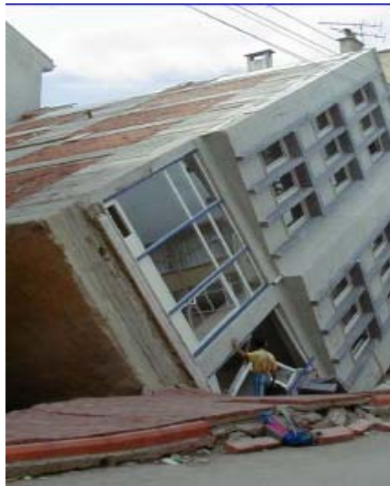
Figure 1.3 : Pivotelement d'un bâtiment (Adapazari, Turquie 1999) [2].
