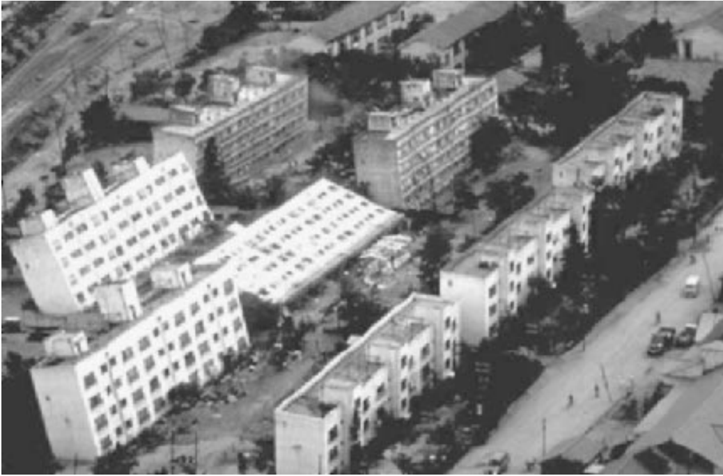
Figure 1.2: Effondrement des bâtiments (Niigata, 1964) [1].
