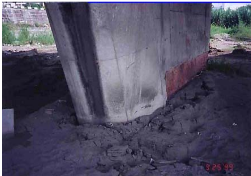
Figure 1.7 : Soulèvement des structures (Taichung, Japon 1971) [2].
