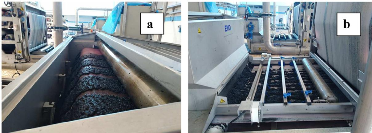
**Figure I.10 :** Tables d'égouttage et filtres à bandes presseuses (a, b) [18].
