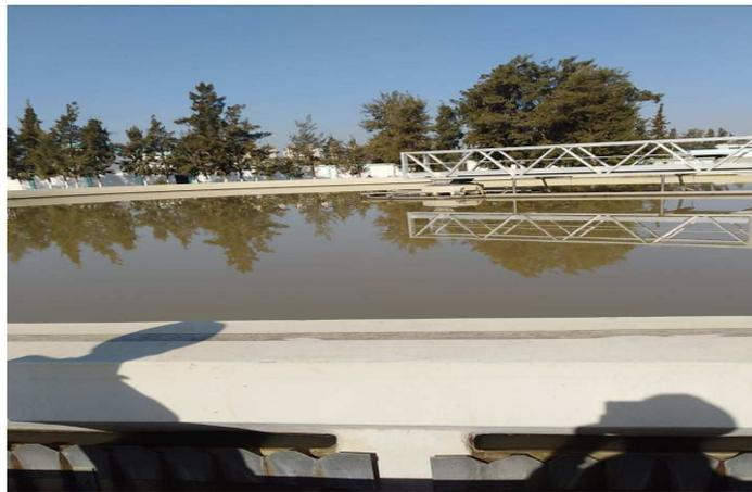
**Figure I.8 :** Le décanteur secondaire ou le clarificateur.
