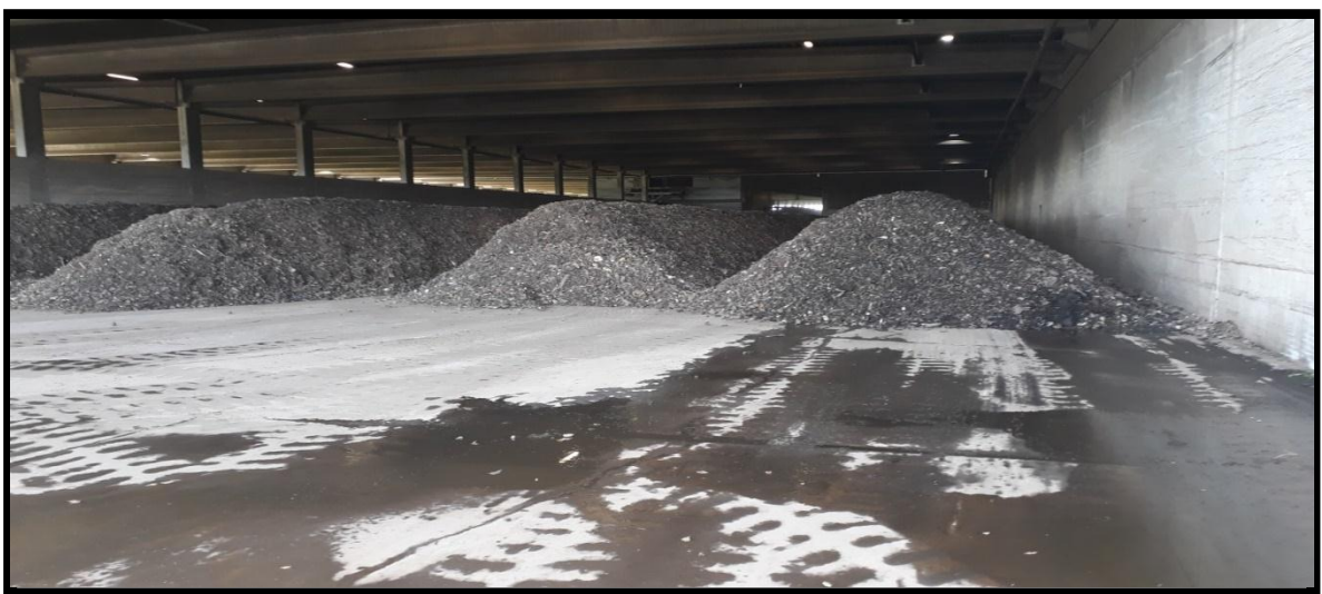
Figure III.3 :Hangar de compostage en Allemagne.
