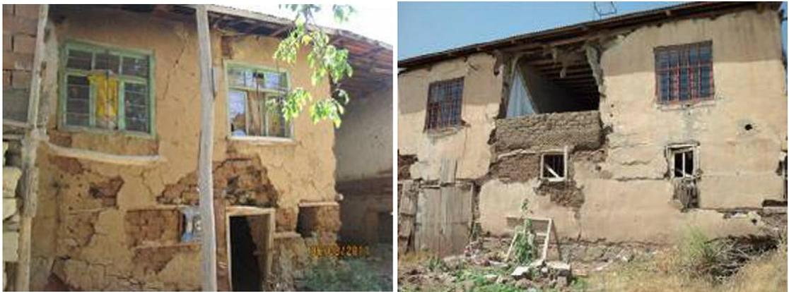
Figure 1.14: Rupture de murs perpendiculairement à leurs plans de maisons de deux niveaux construites en adobe [9]
