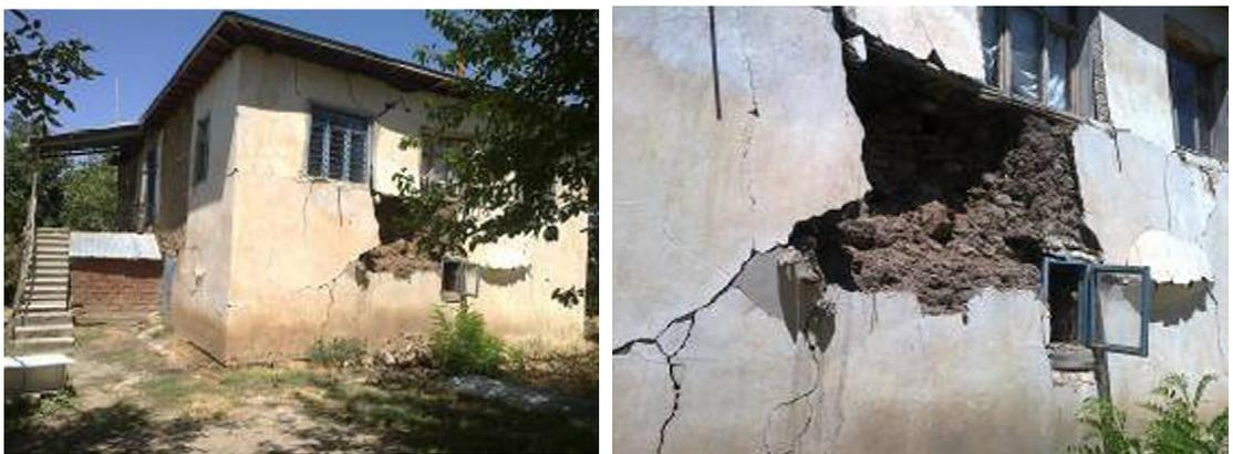
Figure 1.15: Rupture de mur d'une maison en maçonnerie [9]
