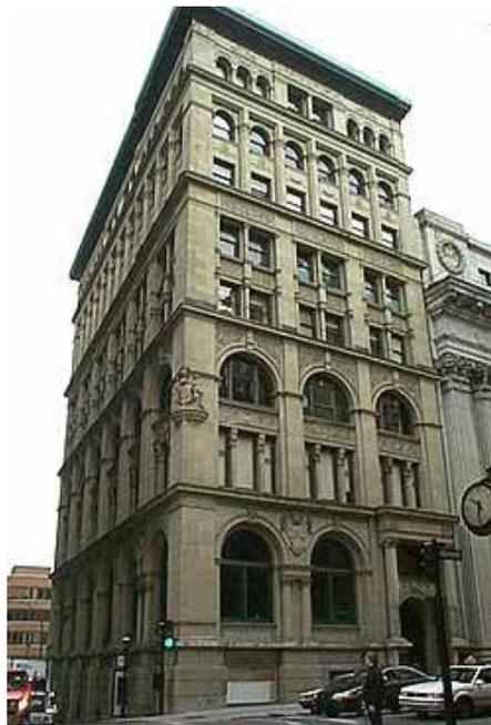
Figure 1.9: 1894, Montréal Canada Life Insurance Building Rue St Jacques 8 étages, ossature murs de maçonnerie porteuse [7]
