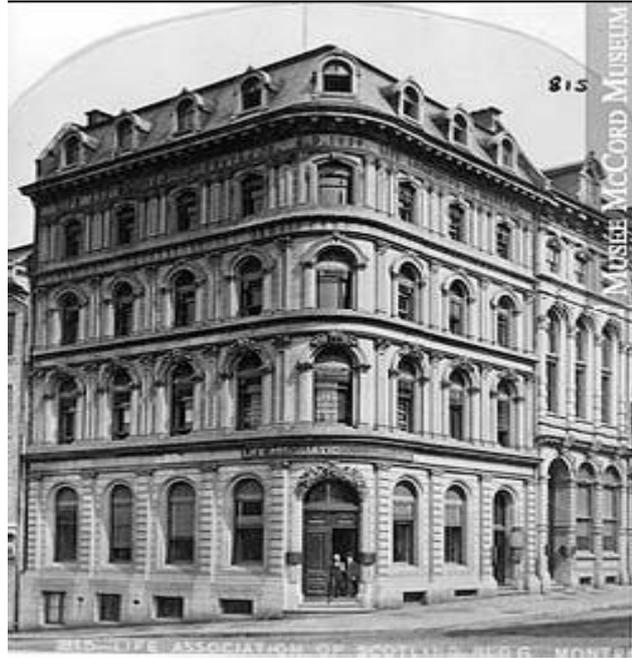
Figure 1.8: Montréal 1870, Great Scottish Life Insurance, fonte et murs porteurs en maçonnerie à 4 étages [7]
