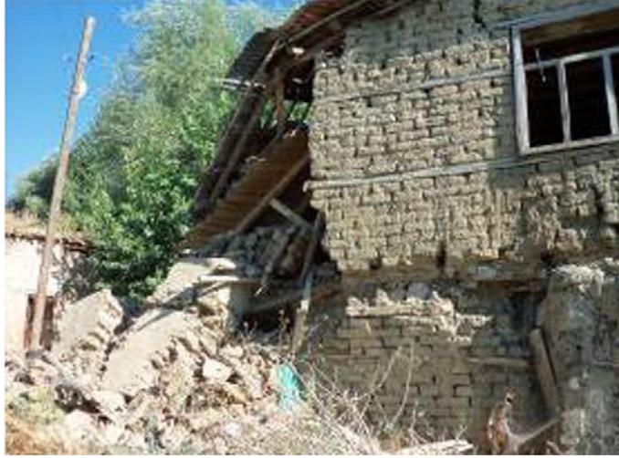
Figure 1.13: Rupture à l'angle d'un bâtiment construit en adobe [9]
