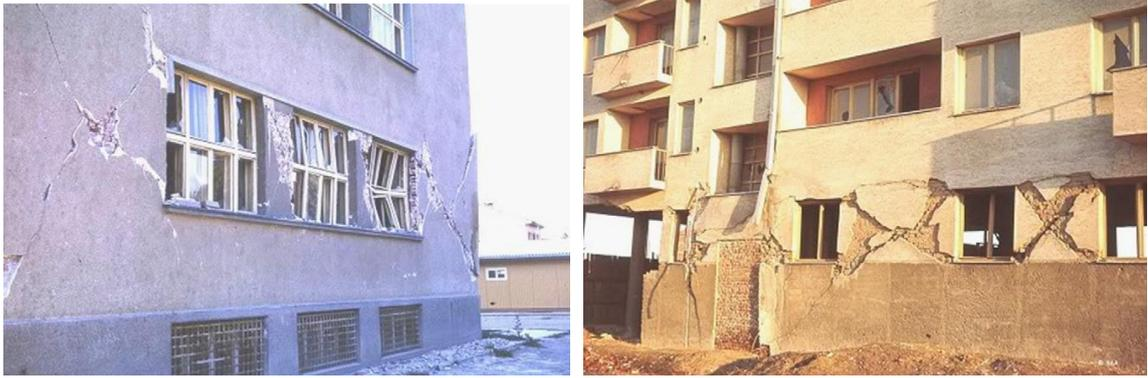
Figure 1.16: Rupture de murs en maçonnerie par cisaillement [10]
