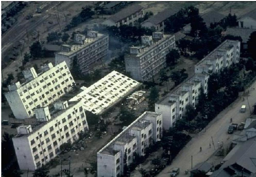
**Figure 1 : Basculement d'immeubles suite au séisme de Niigata 1964 (Johansson, 2000 ; Jefferies et Been, 2006 ; Idriss et Boulanger, 2008).**
