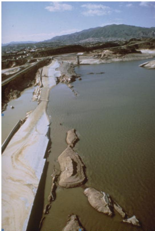
*Figure 3 : Effondrement du parement amont du barrage de San Fernando (Leyendecker, 2012).*
