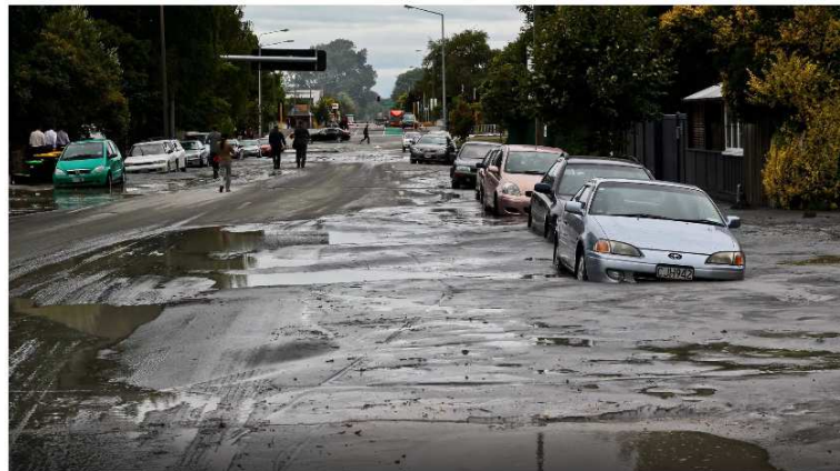
Figure 5.1 Liquéfaction du sol au Japon
