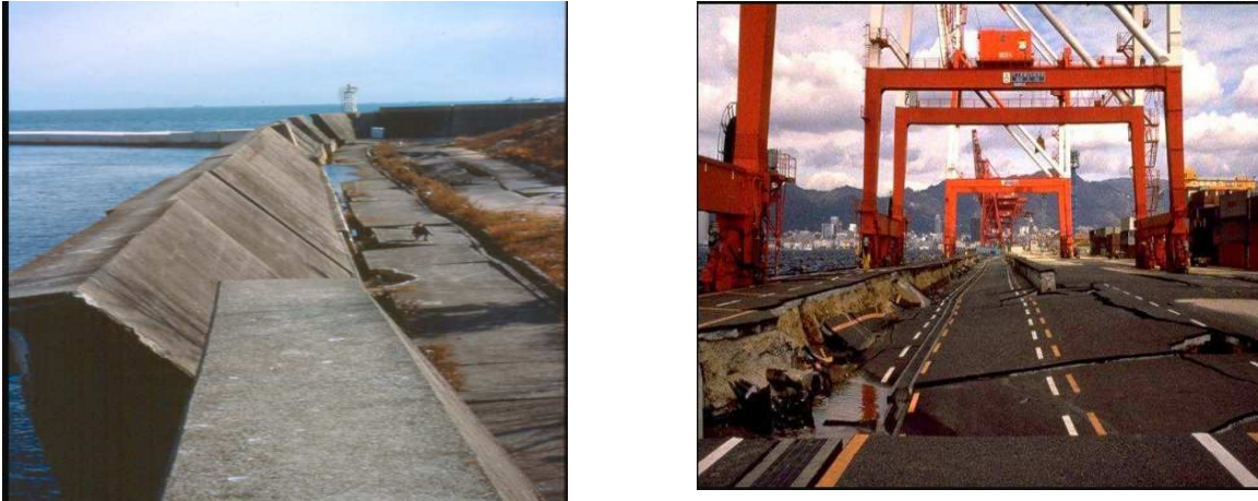
Figure 5.5 Déplacement latéral d'un mur de quai.
