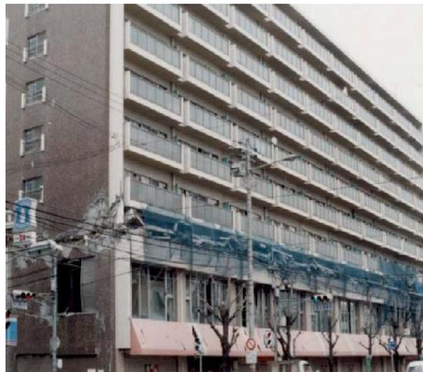
Figure 1.14 : Les effondrements du niveau intermédiaire dus à des changements brusques de rigidité ou de résistance des éléments verticaux (Kobe 1995) [24].
