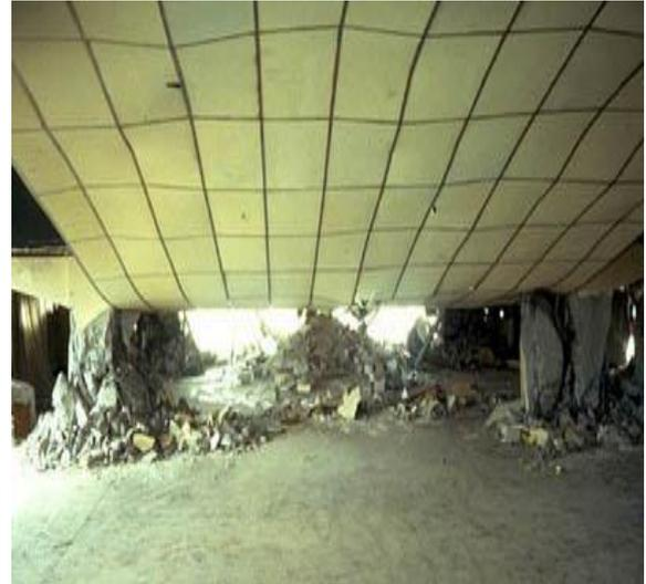
(b) Effondrement de deuxième étage en raison de rupture par cisaillement des poteaux.
