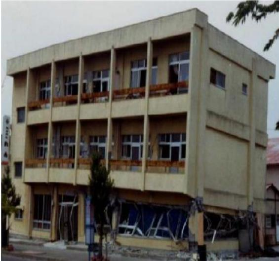
**(a)** Vue d'ensemble des dommages causés à un bâtiment en béton armé de trois étages.
