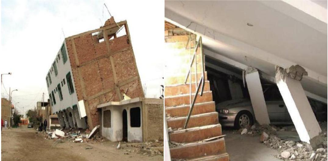
(a) L'effondrement de l'étage de la structure en Béton armé.
