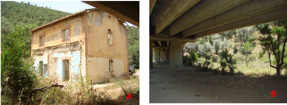
Figure 3.3: Station 1 (A: La maison de la gare; B: le pont).
