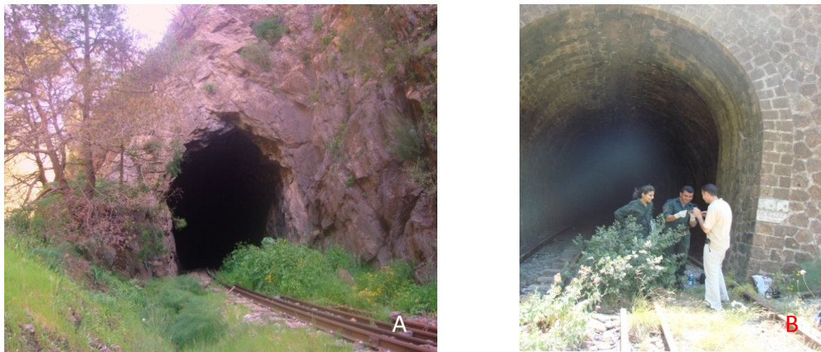
Figure 3.2: L'entrée des tunnels dans la station 1 (A : T3; B : T4).
