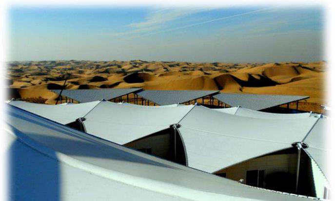
Figure II- 19: la toiture membrane
