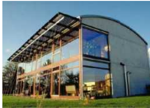
Figure 19 : construction optimisé pour profiter de l'ensoleillement
