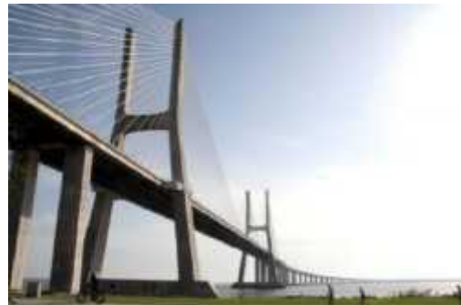
Figure 28 : câble de retenue
