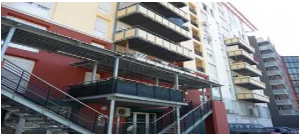
Figure 44 : Nouvelle façade pour les bâtiments réhabilités, tel que l'envoi dans cette image, avec le changement de textures ainsi que l'ajout de balcons, et aussi l'intégration du commerce aux RDC
