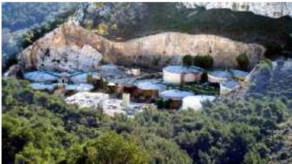
Figure 23 : Station d'épuration des eaux usées, Les Calanques, Marseille
