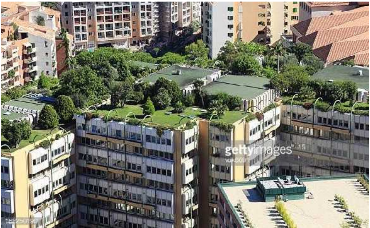
Figure 27 : Intégration des toitures végétales, Monte-Carlo, France
