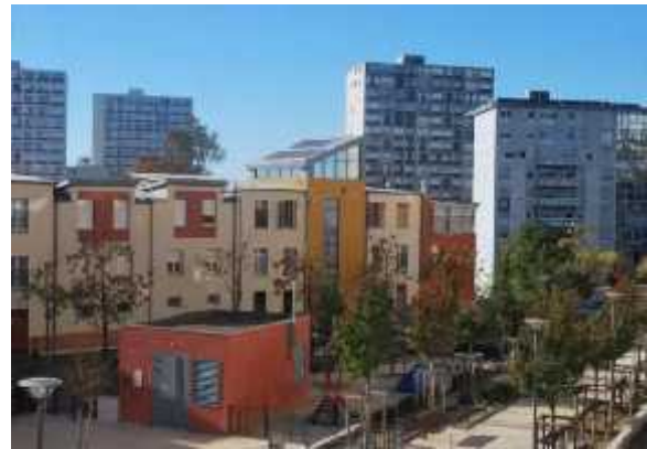
Figure 42 : Contraste clair entre les immeubles reconstruits – dans le bas du quartier – et les barres qui sont en projet de rénovation (Textures, Gabarits, Espaces publics)
