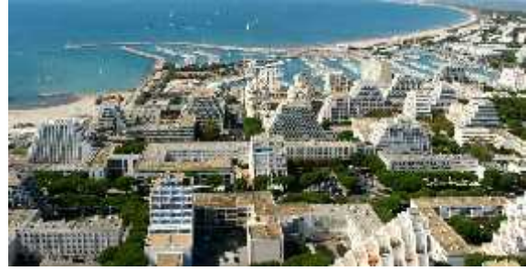
Figure 26 : La grande motte, Exemple d'intégration urbaine, Montpellier Hérault
