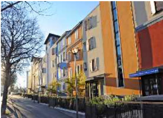
Figure 43 : une rue aux façades colorées et au trottoir aéré avec un habitat en adéquation avec son environnement et plus à l'échelle humaine.
