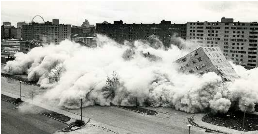
Figure 2: Opération de démolition à Saint-Louis, USA
