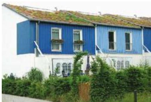
Fig : 30 Un exemple d'une toiture végétalisée
