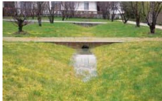
Fig : 31 Une noue pour ralentir l'écoulement des eaux pluviales
