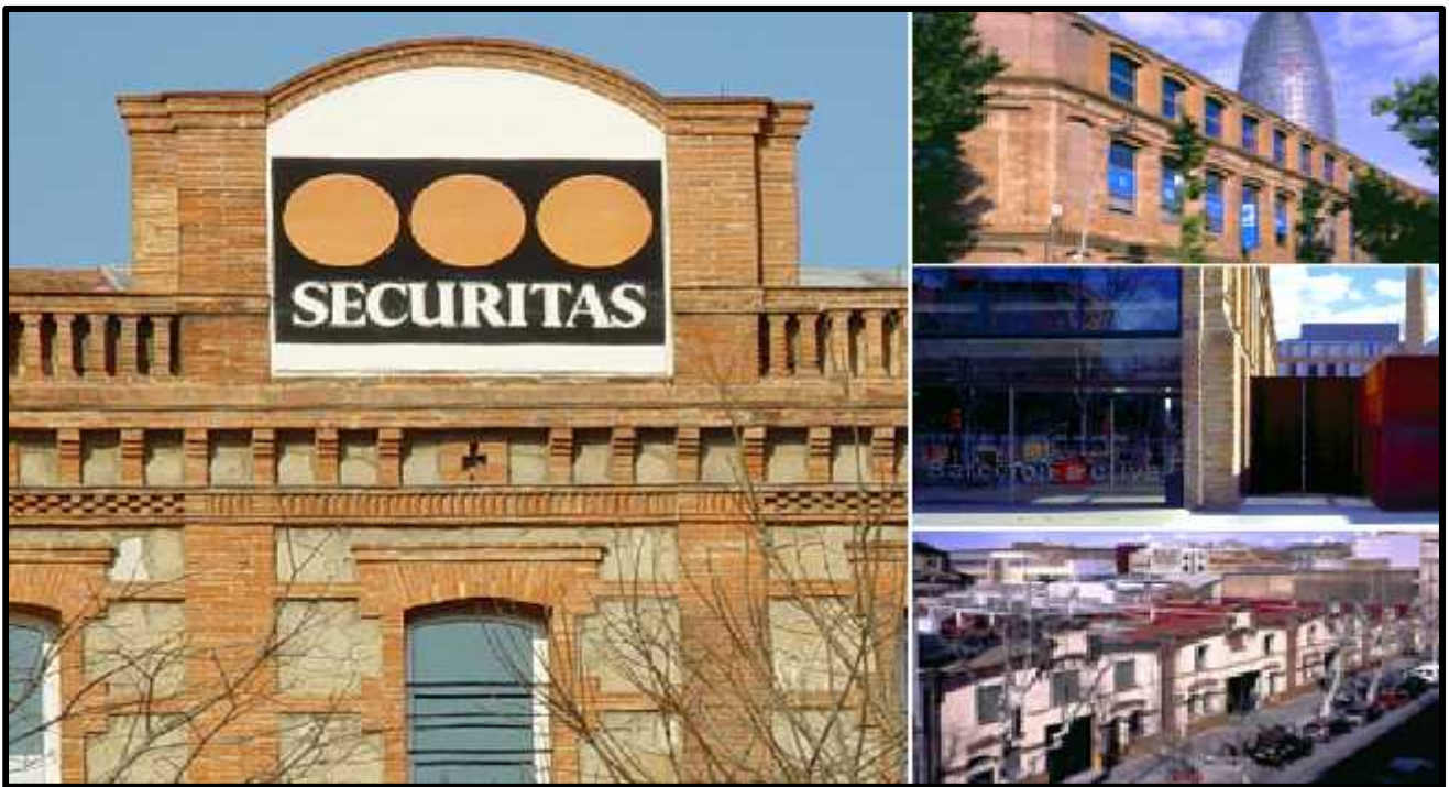
FIG II.17 : patrimoine industrielle du projet 22@ - Barcelone - Source : La transformation urbaine des zones industrielles de Poblenou
