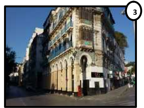
FIG III.10 : Galerie commerciale Source : auteurs 2018.
