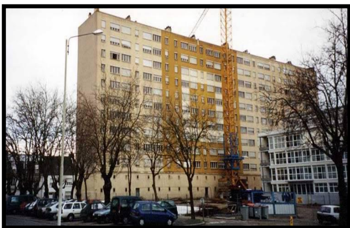
Figure29: habitat Quai de Rohan avant restructuration
