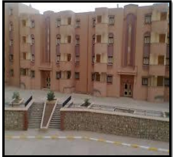
Figure 28 Un immeuble d'habitation à Djelfa, Source: http://www.vitamedz.com/fr/algerie/Urbanisme/670/Photos/184.html
