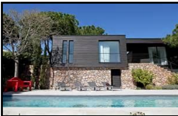
Fig. 15: Maison en bord de la mer qui utilise la pierre et le bois Source: immoneuftunisie.com
