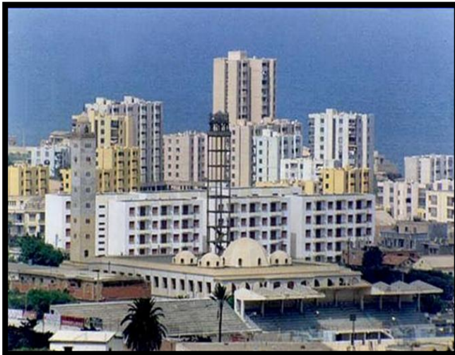
Figure 49 : Les nouvelles habitations le long de la RN11.
