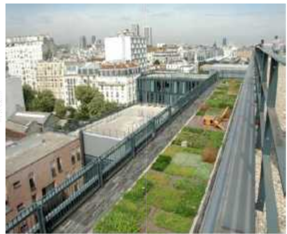
Figure I-6 : Toiture semi-intensive d'un bâtiment administratif, avenue de France Source : Komitès, 2017
