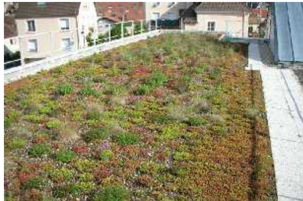
Figure I-14 : Toiture végétalisée de la Mairie des Mureaux, France Source : www.vegetalid.fr
