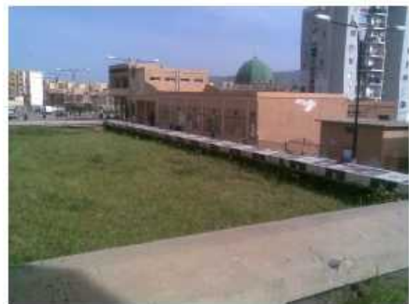
Figure I-8 : Toiture végétalisée à Bouira Source : Atik, 2011
