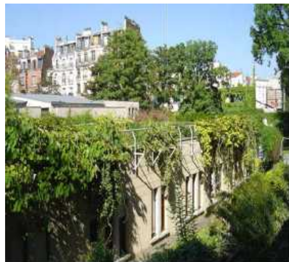
Figure I-2 : Toiture intensive d'un bâtiment administratif à Paris Source : Komitès, 2017
