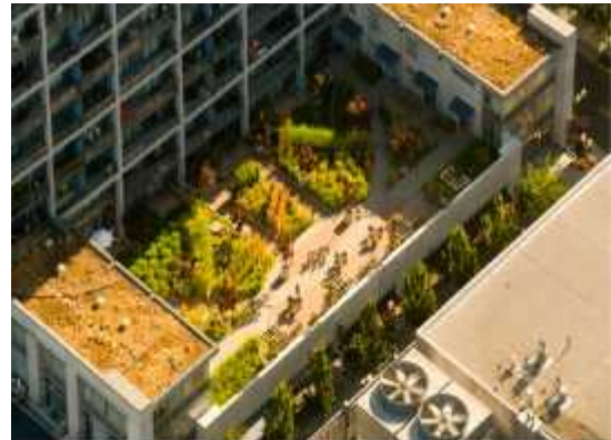
Figure I-15 : Terrasse-jardin Immeuble 'The Louisa' à Portland
