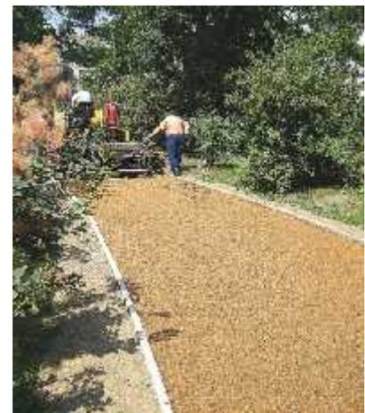
**Figure III.61** : Asphalte en végécol transparent.
