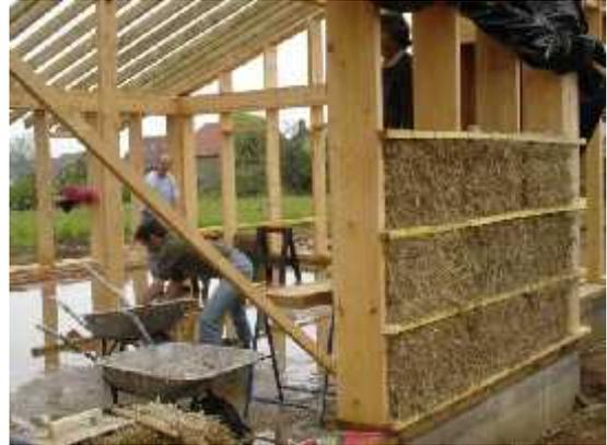
**Figure III.91:** Remplissage en botte de paille.
