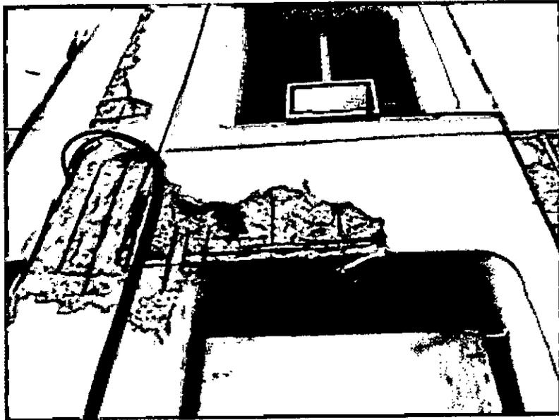
**Figure 1.6** : Corrosion d'aciers dont l'enrobage ne respecte pas les dispositions réglementaires du BAEL en atmosphère corrosive [11]
