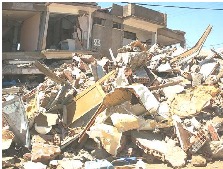
Figure 3.7 : Mécanisme de ruine partiel*
