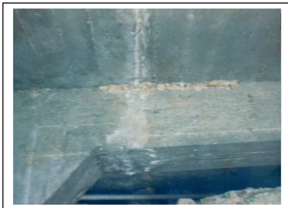
Figure III-1 Pont sur oued de Reghaia (ancienne RN 05 au PK 29+900)
