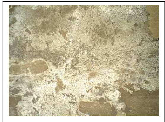
Figure III-2 Mortier de protection d'un mur (Stade el- harrach)
