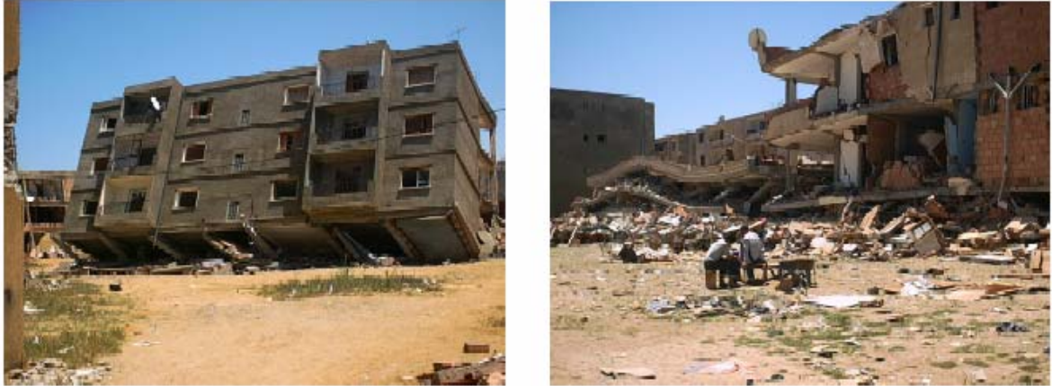
Figure 4.2 : Rupture du 1 er niveau flexible
