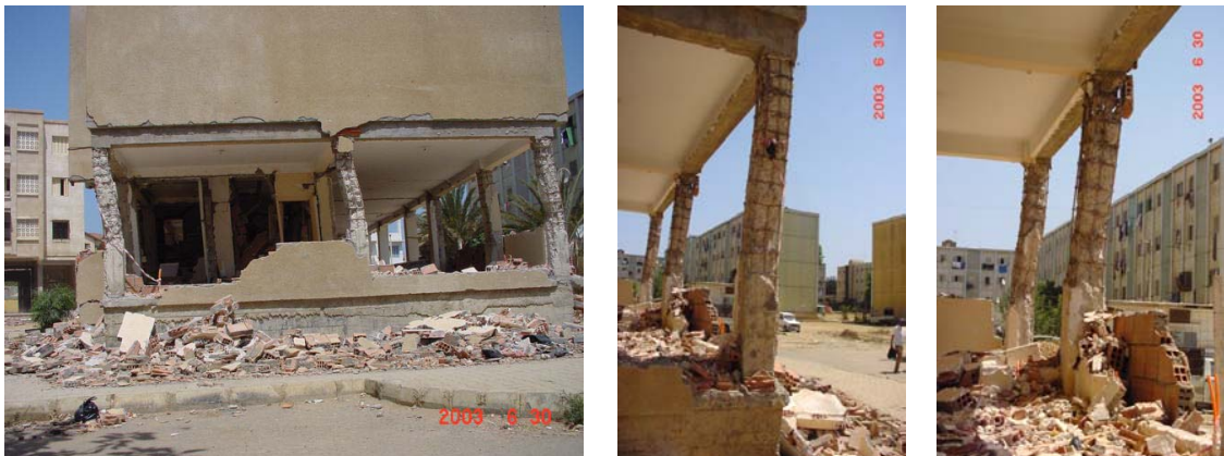
Figure 1.29 : Effet de non confinement du Béton
