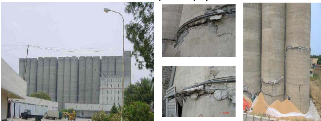
Silos de Corso
