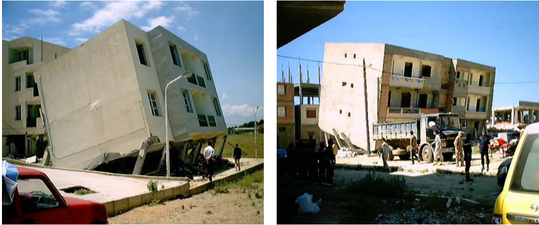
Figure 1.22 : Conséquences des étages souples
