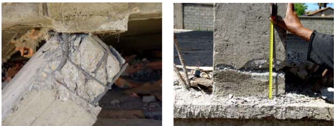
Figure 1.26 : Présence des talonnettes
