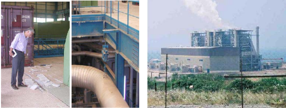
Centrale thermique de Cap Djinet
