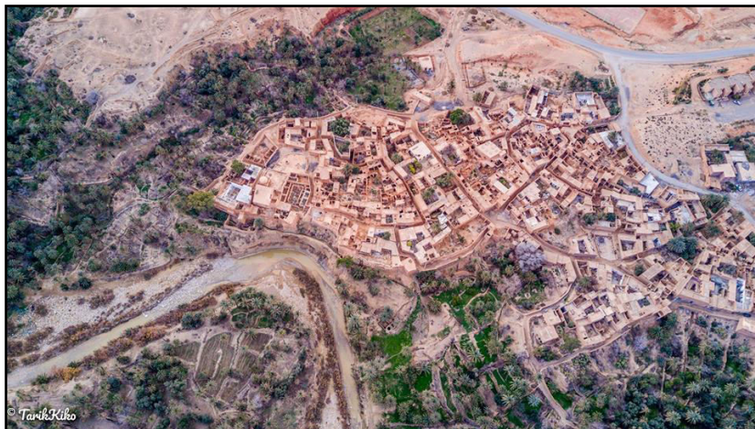
Fig. 2.34 : Le bâti du Village Rouge.
