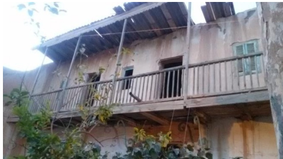
Figure 48: vue sur el Ali de la maison
