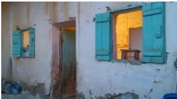
Figure 47 : l'entrée de la maison
