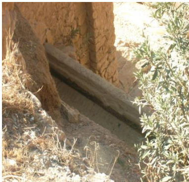
Annexe 05 : barrage de décharge
