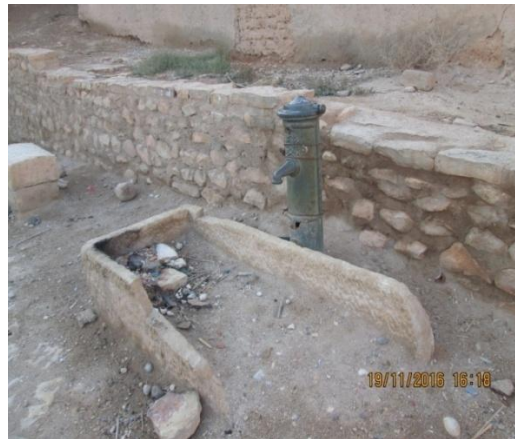
Figure 33 : Puits après les travaux de restauration 2013.
