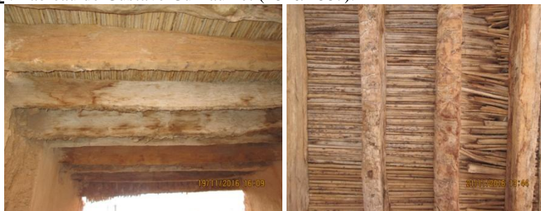
figure 41 /42 : plancher en tronc de palmier
