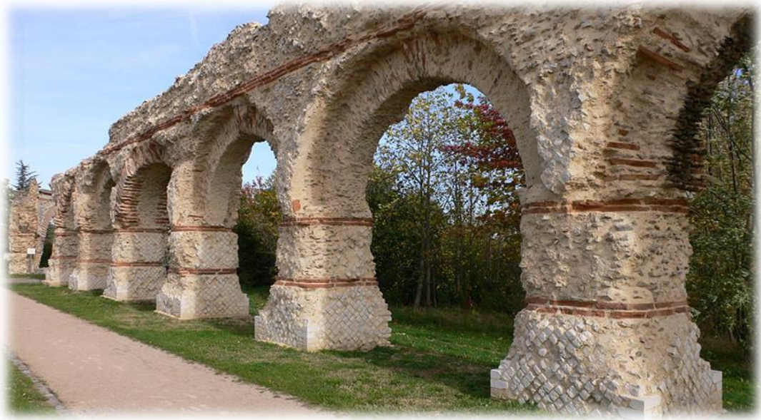
Figure 08 : Aqueduc Romain du GIERS
