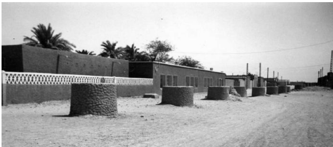
Figure 16 : Alignement des puits d'une foggara à Timimoune
