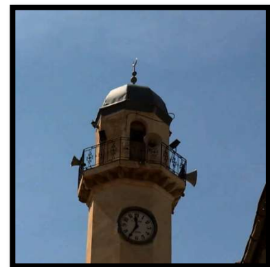
FIGURE 14 : Le lanterneau et la coursive du minaret
