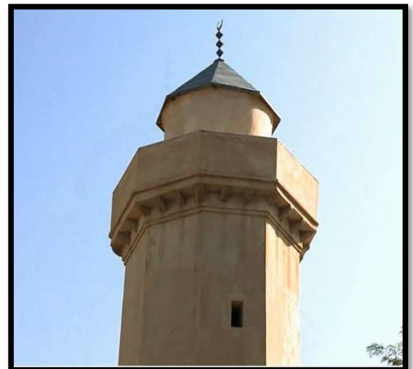
FIGURE 30 : La tour principale du minaret.
