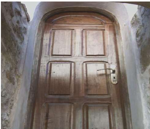
FIGURE 32 : L'entrée du minaret.
