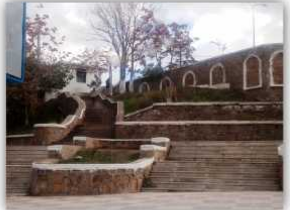
Figure 54: Vue sur la placette et l'escalier urbain
