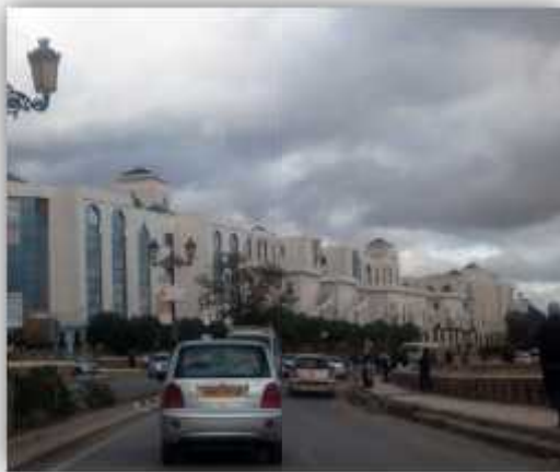
Figure 57: Vue du nouveau pôle universitaire
