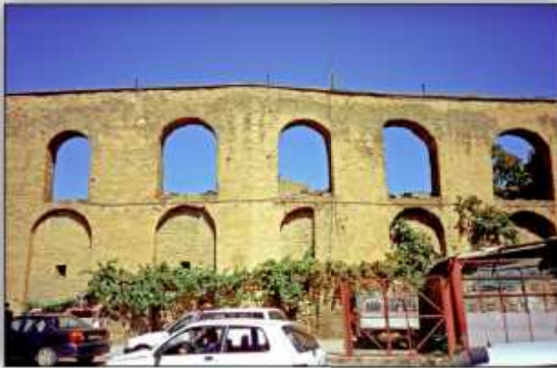
Figure 36: L'aqueduc romain de Médéa
