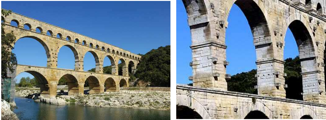
Figure -1.9- Le Pont de Gard à Nîmes, France environ 20 apr. J.C [5].
