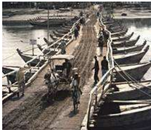
Figure -1.8- Pont flottant (Pakistan) Ce pont traverse le Kabul, affluent de l'Indus [1]
