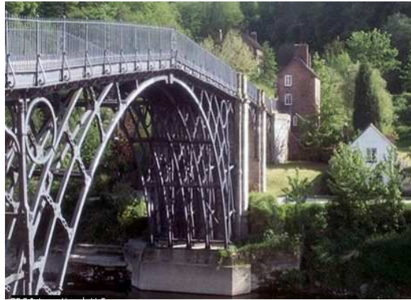
Figure- 1.19- Pont en fonte à Coalbrookdale, Grande Bretagne 1779 [10]
