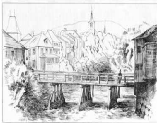
Figure -1.6 - Premier pont en bois de la ville de Boudry Composé d'un plancher [6]
