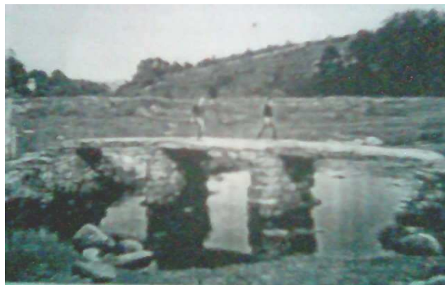
Figure -1.7- Pont de Dartmoor en Grande-Bretagne [5]
