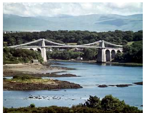
Figure -1.27 - Pont suspendu du détroit de Menai [1]
