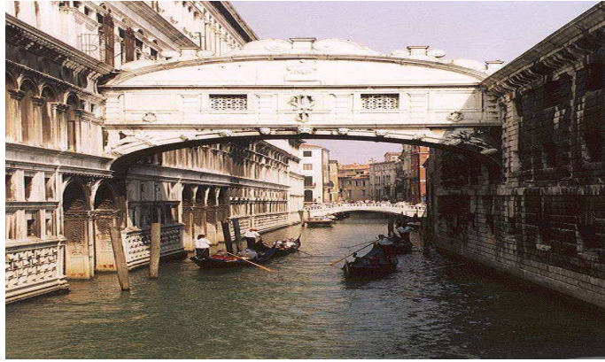
Figure- 1.15- Le pont des Soupirs [8]
