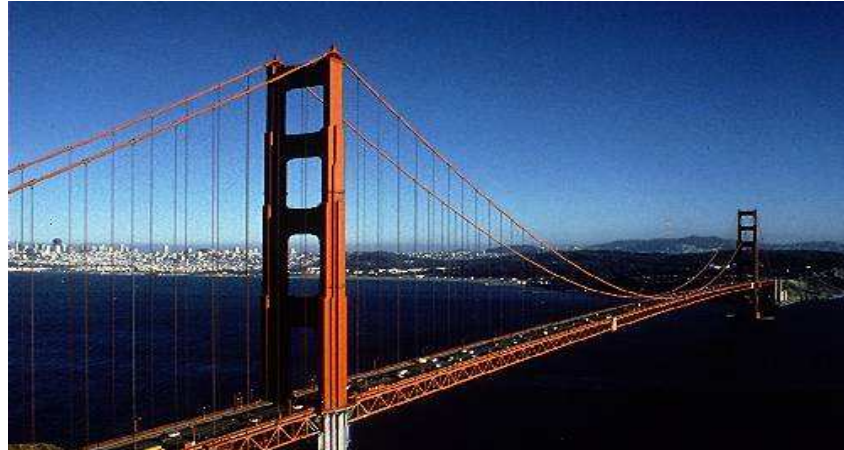
Figure-1.29- Pont du Golden Gate, Californie, États-Unis [1]
