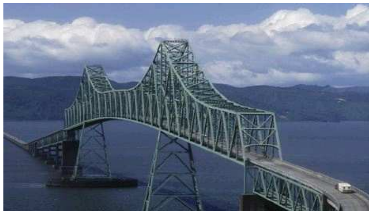
Figure -1.18- Le Pont Astoria (État de Washington) 1966 [1]
