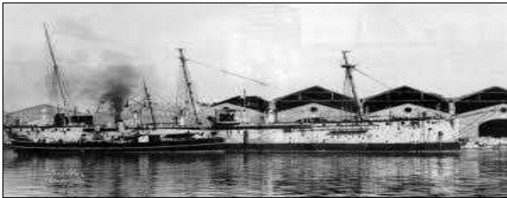
Figure 8 : La Tesa 105 dans son état initial. Source : site internet
