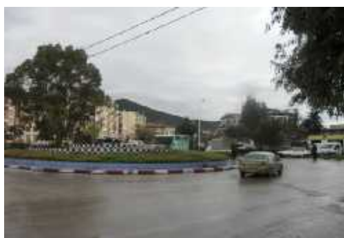
Figure 35: Vue sur un nœud principal. Source : auteur
