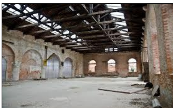
Figure 11 : La Tesa 105 dans son état initial (intérieur)
