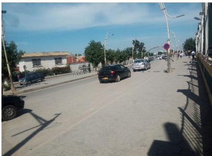
Figure 66: Vue sur la 1 ÈRE partie de la RN°42. Source : auteur
