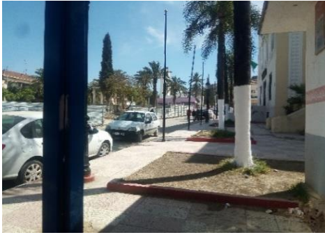
Figure 73: Vue sur l'axe a El Affroun. Source auteur
