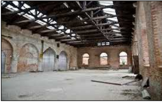
Figure 9 : La Tesa 105 dans son état initial (intérieur)
