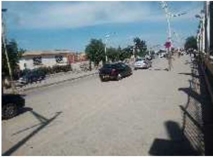
Figure 23: Vue sur la 1ÈRE partie de la RN°42. Source : auteur
