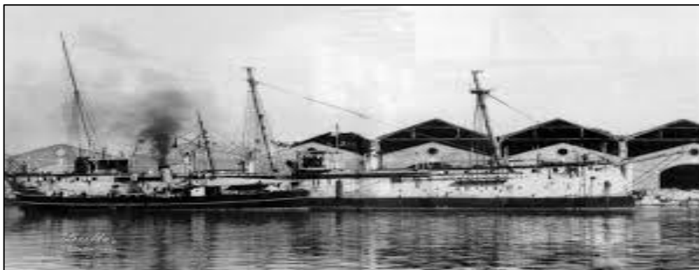
Figure 9 : La Tesa 105 dans son état initial. Source : site internet
