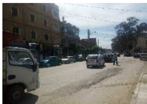
Figure 34: Vue sur un nœud secondaire. Source : Auteur
