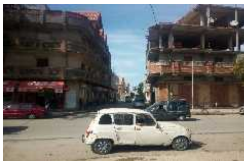
Figure 32: Vue sur l'un des axes tertiaires. Source auteur
