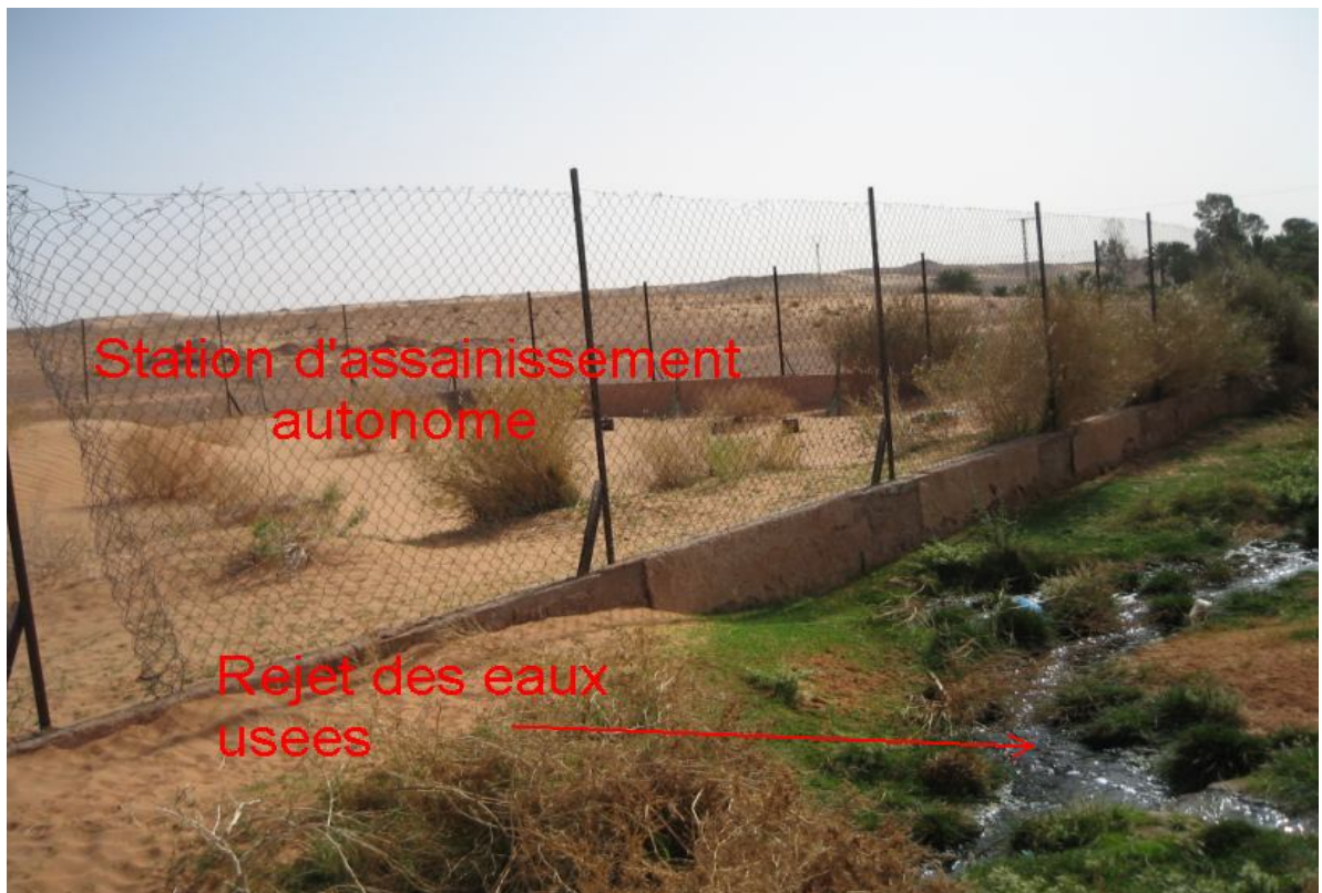
Photo 4.7 Rejet des eaux usées a ciel ouvert
