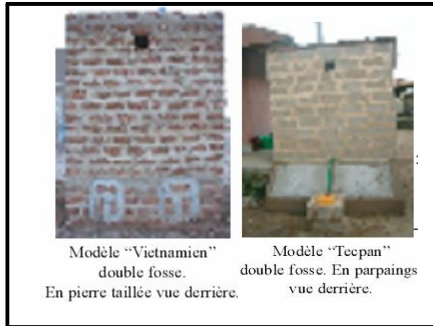
Figure 1.2. Schéma d'une latrine à double fosse.
