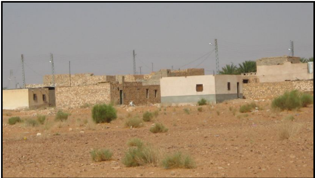
Photo 4.3 vue générale des nouvelles habitations de Ain LOUSSIG
