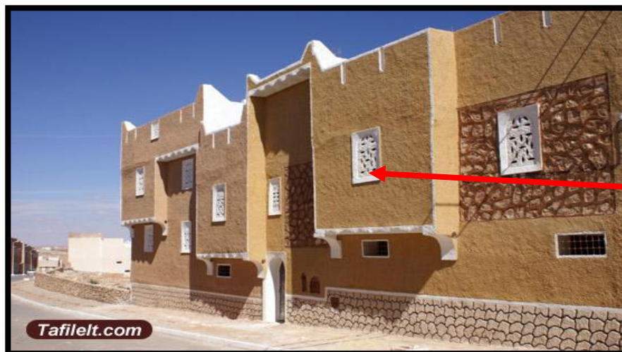
Figure 28 l'utilisation des petite ouvertures a ksar Tafilelt
