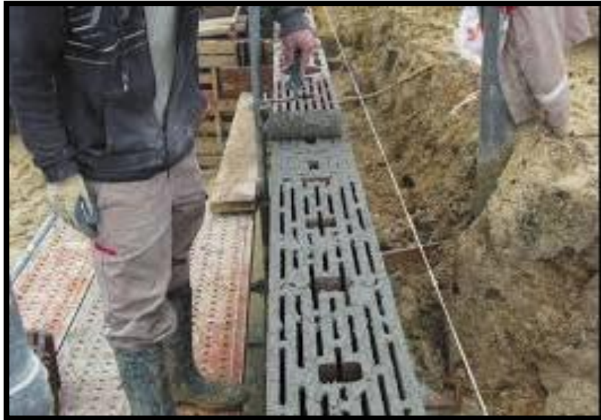
Figure 38: la mise en œuvre du calimur c20
