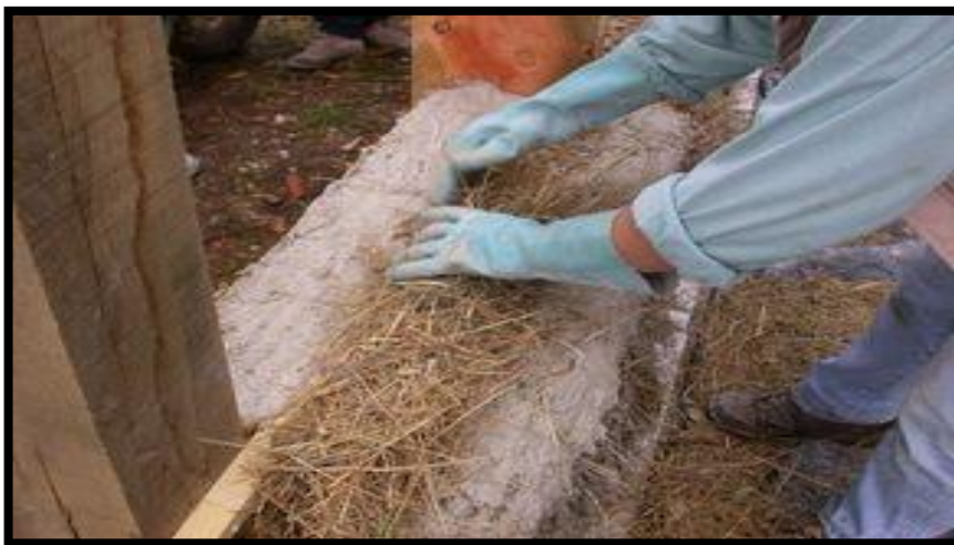
Figure 41: la mise en œuvre du foin
