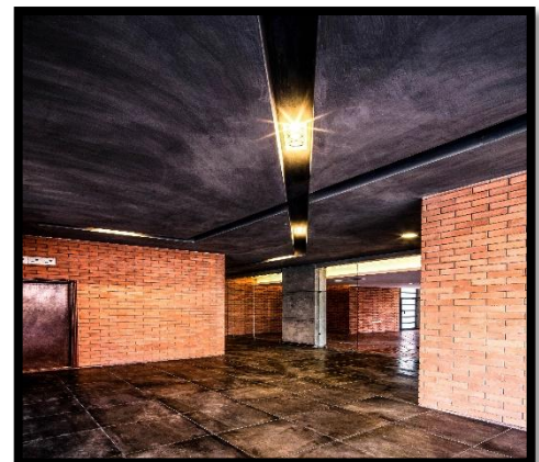
Figure 54 :le revêtement en brique de l'immeuble
