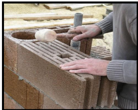
Figure 37: pose précise du calimur c20
