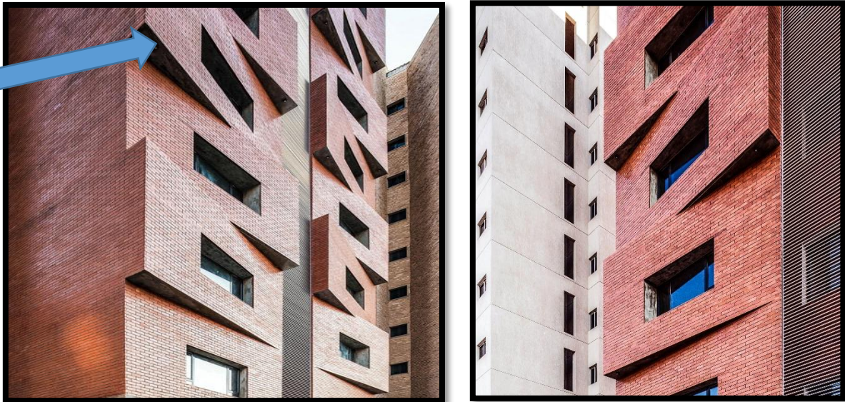
Figure 53 : la façade angulaire de l'immeuble
