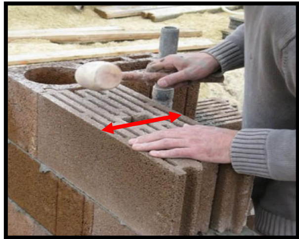
Figure86 : la mise en œuvre de calimur c20
