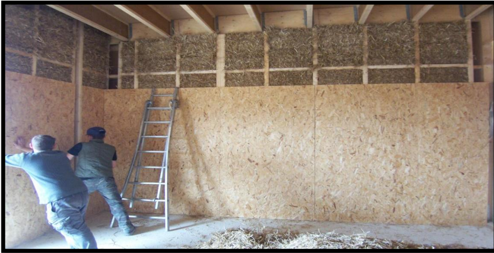
Figure 40: la mise en œuvre du foin
