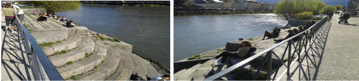
Image 1 e 2. Aménagement des gradins de l'ancien embarcadere Quai Perrière 1
