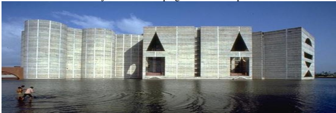
Figure 44. Construction en béton. 2
