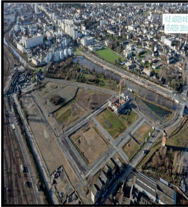
Vue du site avant projet
