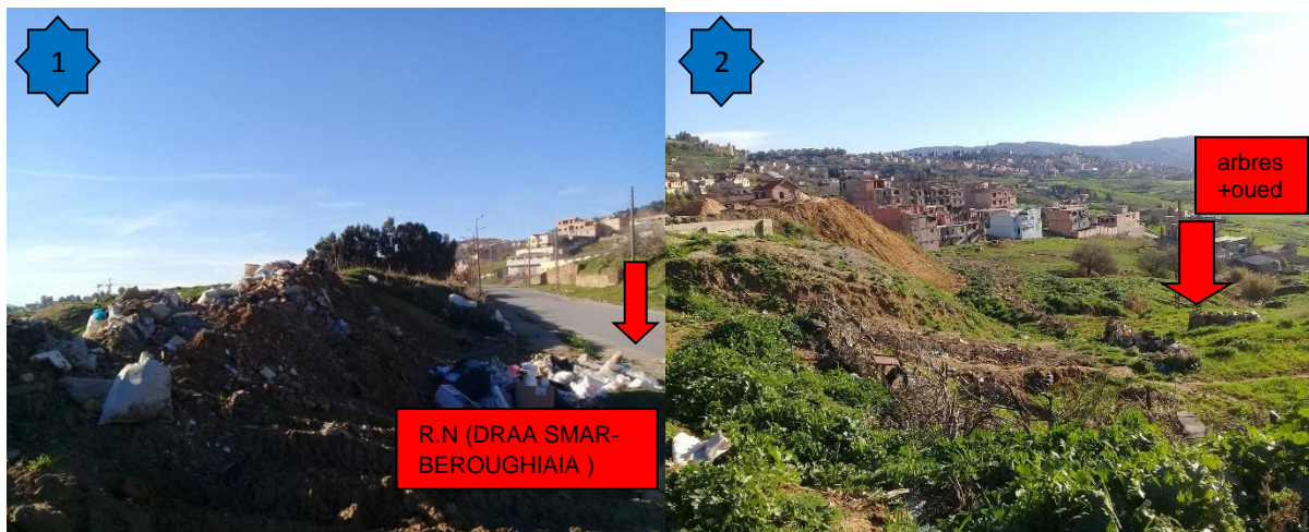
Figure 78;79 SITE D'INTERVENTION Source :prise par l'auteur
