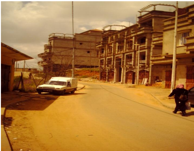
Figure 73 extensions de la ville Médéa source: prise par l'auteur commentaire: traitement de façade se varie et dans le nouveau style
