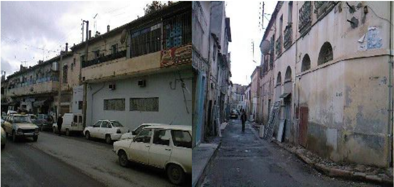
Figure 60;61 centre historique de Médéa source: prise par l'auteur commentaire: dégradation du cadre du bâti
