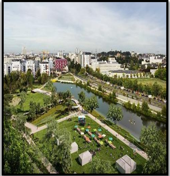
Vue du site après intervention
