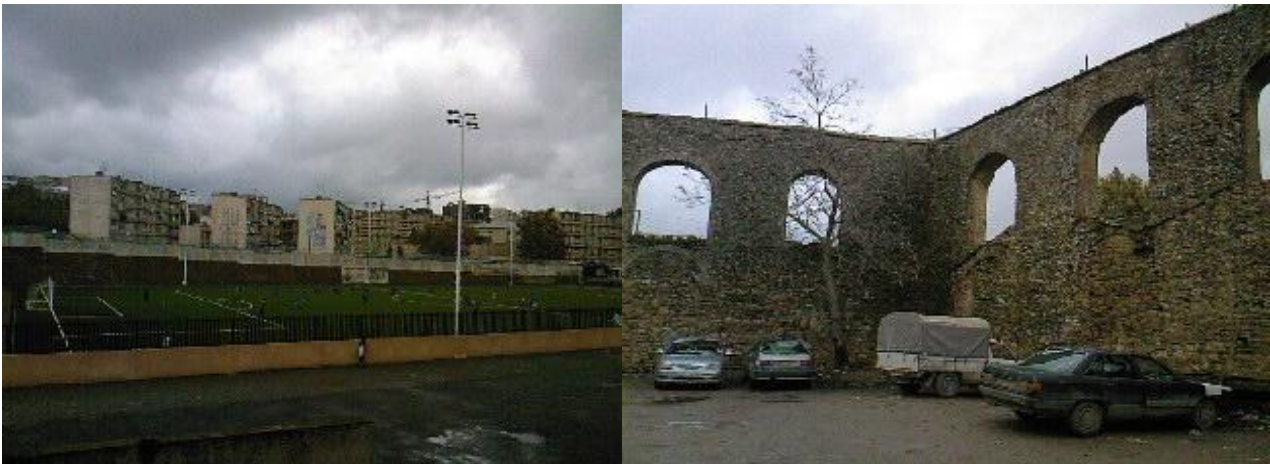
Figure 62 centre historique de Médéa source: prise par l'auteur commentaire: intégration du nouveau style
