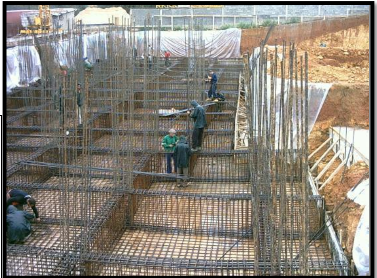
Figure 94: Fondation en radier en travaux. Source : https://www.researchgate.net/figure/La-photo-illustre-la-realisation-dune-fondation-en-radier-dans-le-chantier-de-lhotel_fig1_305790408 https://www.researchgate.net/figure/La-photo-illustre-la-realisation-dune-fondation-en-radier-dans-le-chantier-de-lhotel_fig1_305790408
