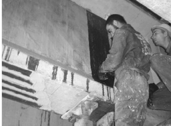
Figure 1.24 : Pose de tissu en fibres de carbone sur la même poutre [44].
