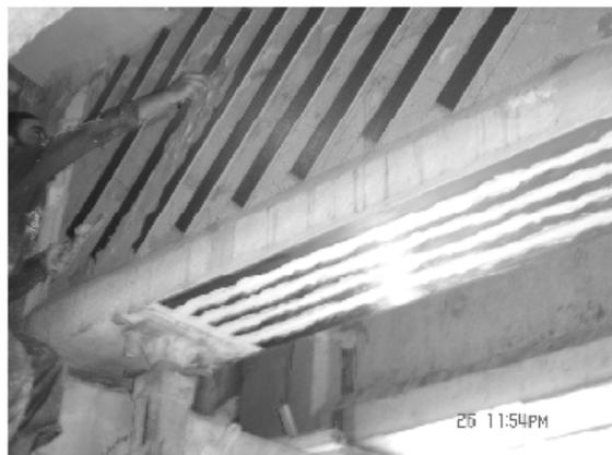
Figure 1.23 : Renforcement par lamelle en fibres de carbone d'une poutre endommagée par le séisme du 21 mai 2003 [44].
