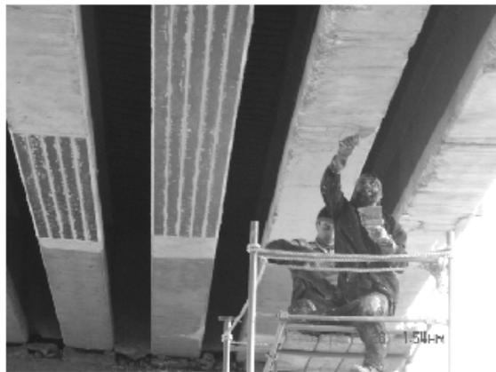
Figure 1.22 : Poutres traitées par mortier de réparation et renforcées par lamelles de fibres de carbone [44].
