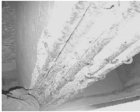
Figure 1.29 : Apparition des armatures et corrosion [45].
