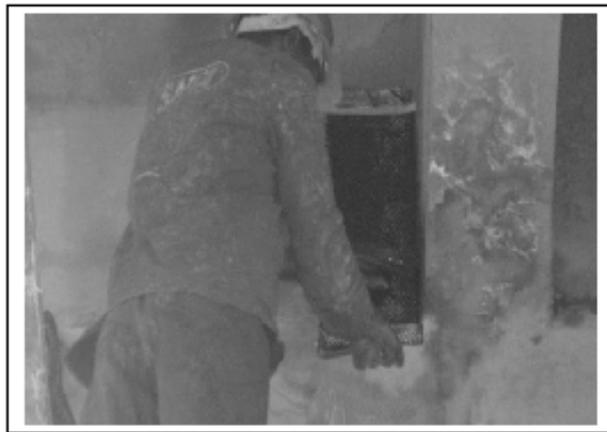
Figure 1.37 : Mise en place du tissu sur les âmes des poutres (bandes à l'effort tranchant) [45].
