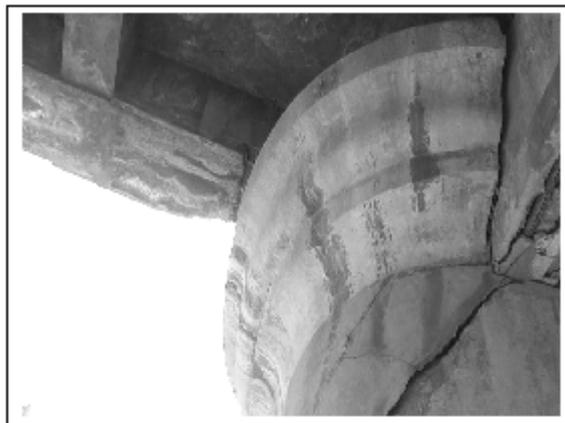
Figure 1.31 : Détérioration des plaques d'appuis au niveau des culées et de la pile [45].
