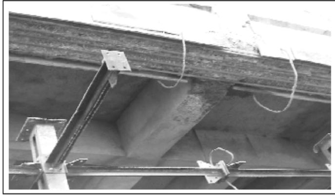
Figure 1.32 : Enlèvement des bétons dégradés et piquage des surfaces dénudées [45].
