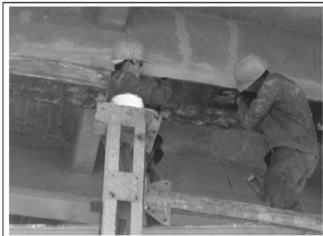
Figure 1.38 : Mise en place du tissu sur les fibres inférieures des poutres (bandes de moments fléchissant) [45].
