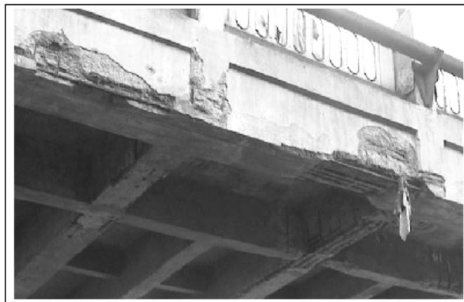
Figure 1.28 : Dégradation du béton du tablier [45].
