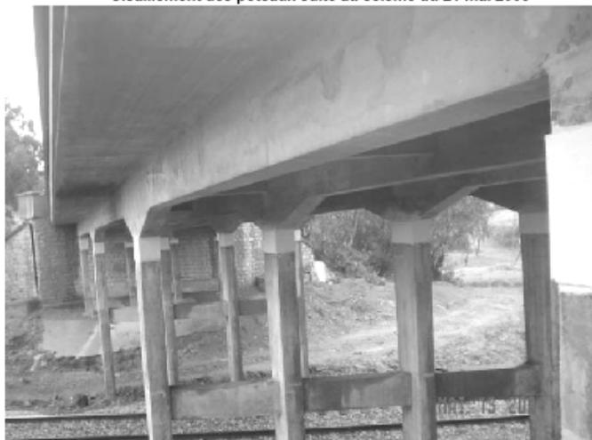
Figure 1.26 : Renforcement des poteaux cisailé par procédé TFC [44].
