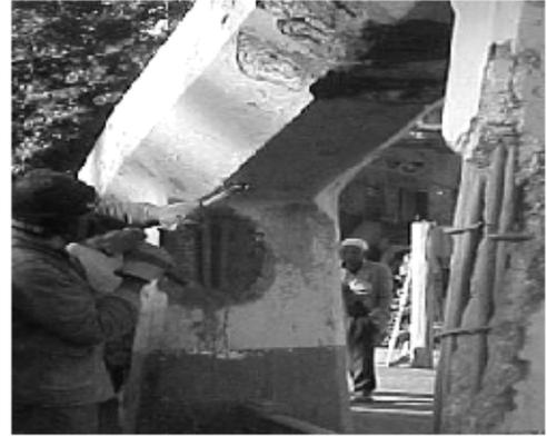
Figure 1.30 : Dégradation du béton des montants [45].
