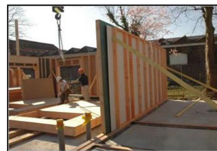
Figure II.64 : matériaux utilisé Source : http://www.atelier981.org
