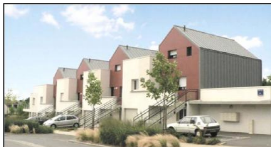
Figure II.45 : logements superposés à plein sud Acigné 35, France Source : ADEUS, C'est quoi l'habitat intermédiaire ?, 2004.
