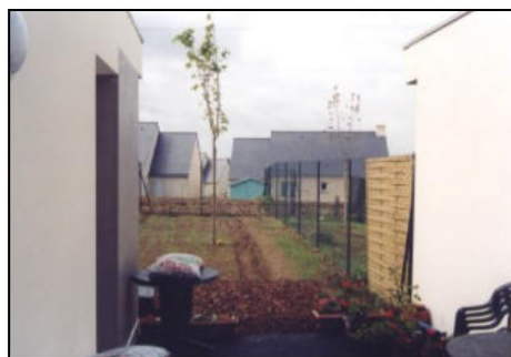
Figure II.50 : Jardin du « Forban », à Plérin, depuis sa partie la plus étroite Source : Etude action sur L 'HABITAT INTERMÉDIAIRE, 2003
