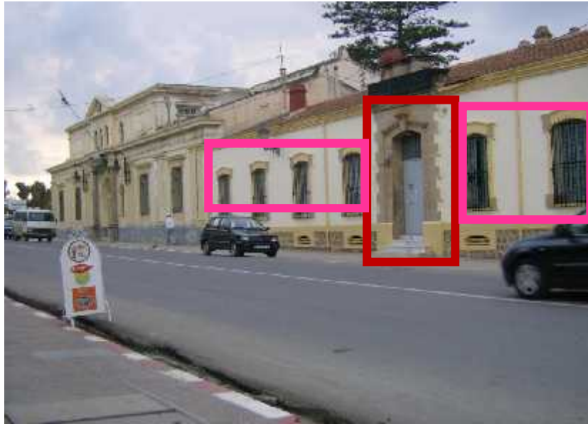
Façade principale de la mairie de Cherchell
