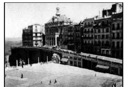
FIG : 33.02 Ouverture de la Place du 1er Novembre 1954 (La Brèche) Source : Loucif : 2009
