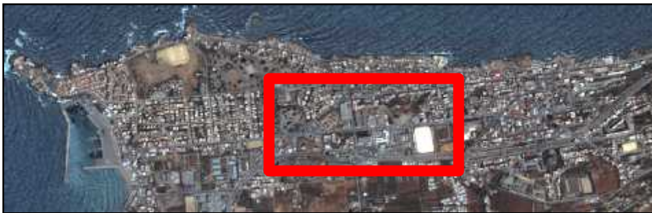
FIG 27.03 : Etat de fait du centre-ville de Ain El Banian Source : Google earth. 2015
