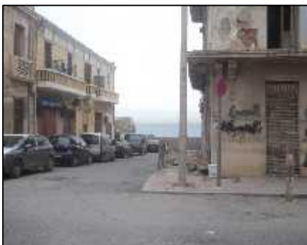
FIG 16.01 : Dégradation sur le plan urbain de la ville d'Ain El Banian. Source: Auteurs 2015
