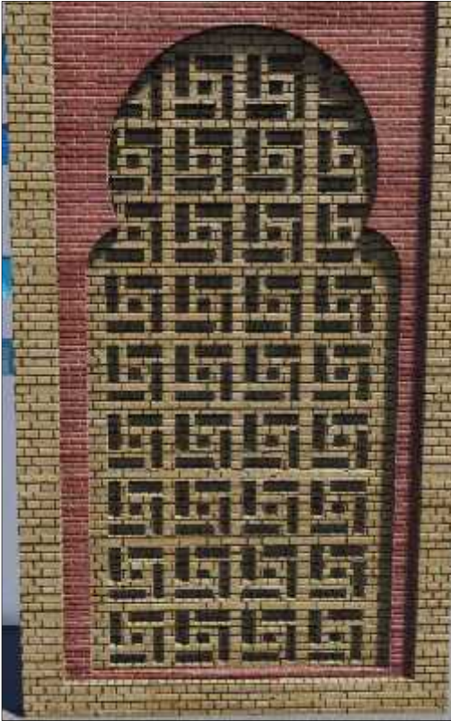
FIG 58.03 : élément signalétique en brique Source : Auteurs. 2015
