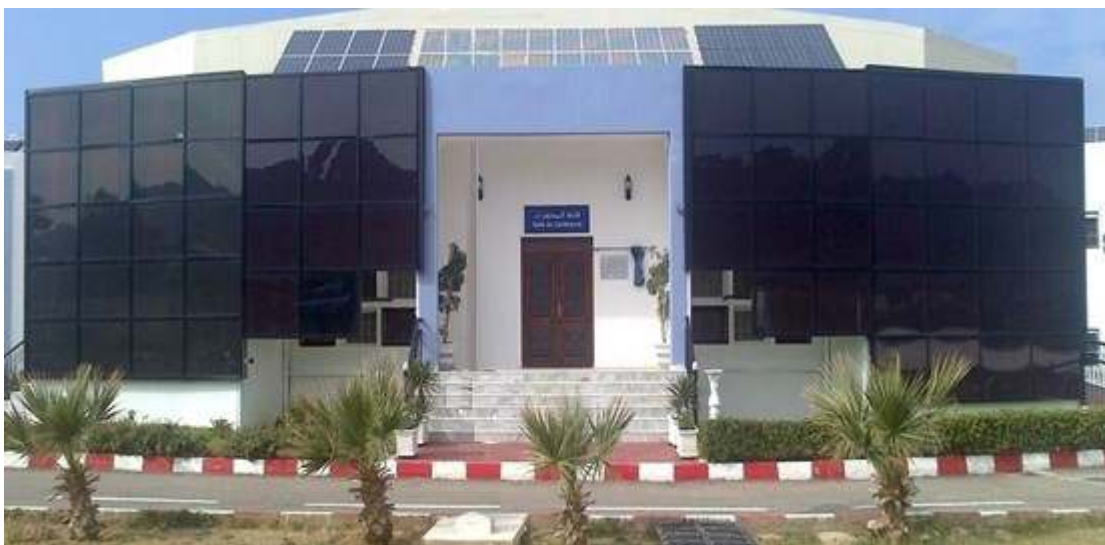
Figure 3.1: La centrale photovoltaïque multi-technologie de l'UDES
