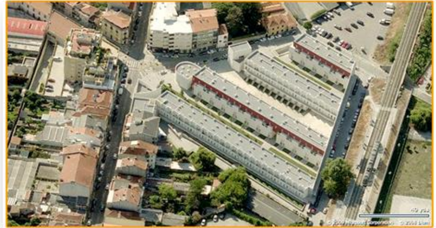
126 logements collectifs à « Bouça »Portugal
